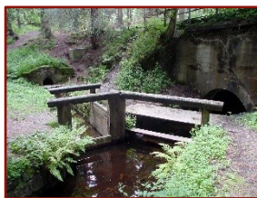
Teil des Dammgrabens. Foto: Welke.
