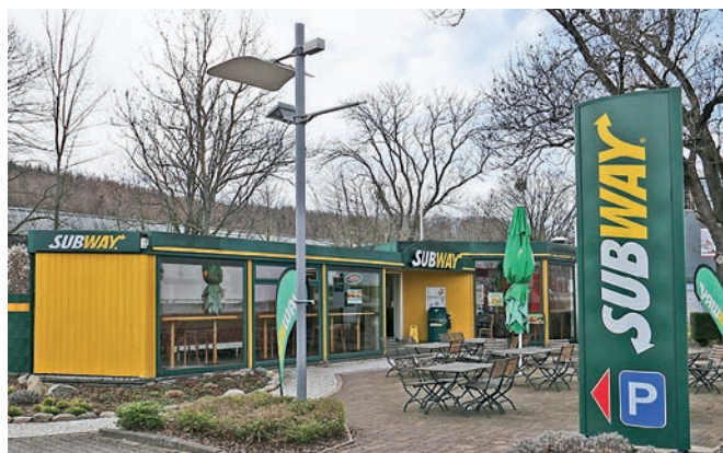
Trelementgebäude des SUBWAY Schnellfood Restaurants, Anbau am ehemaligen Einrichtungshaus Atrium
