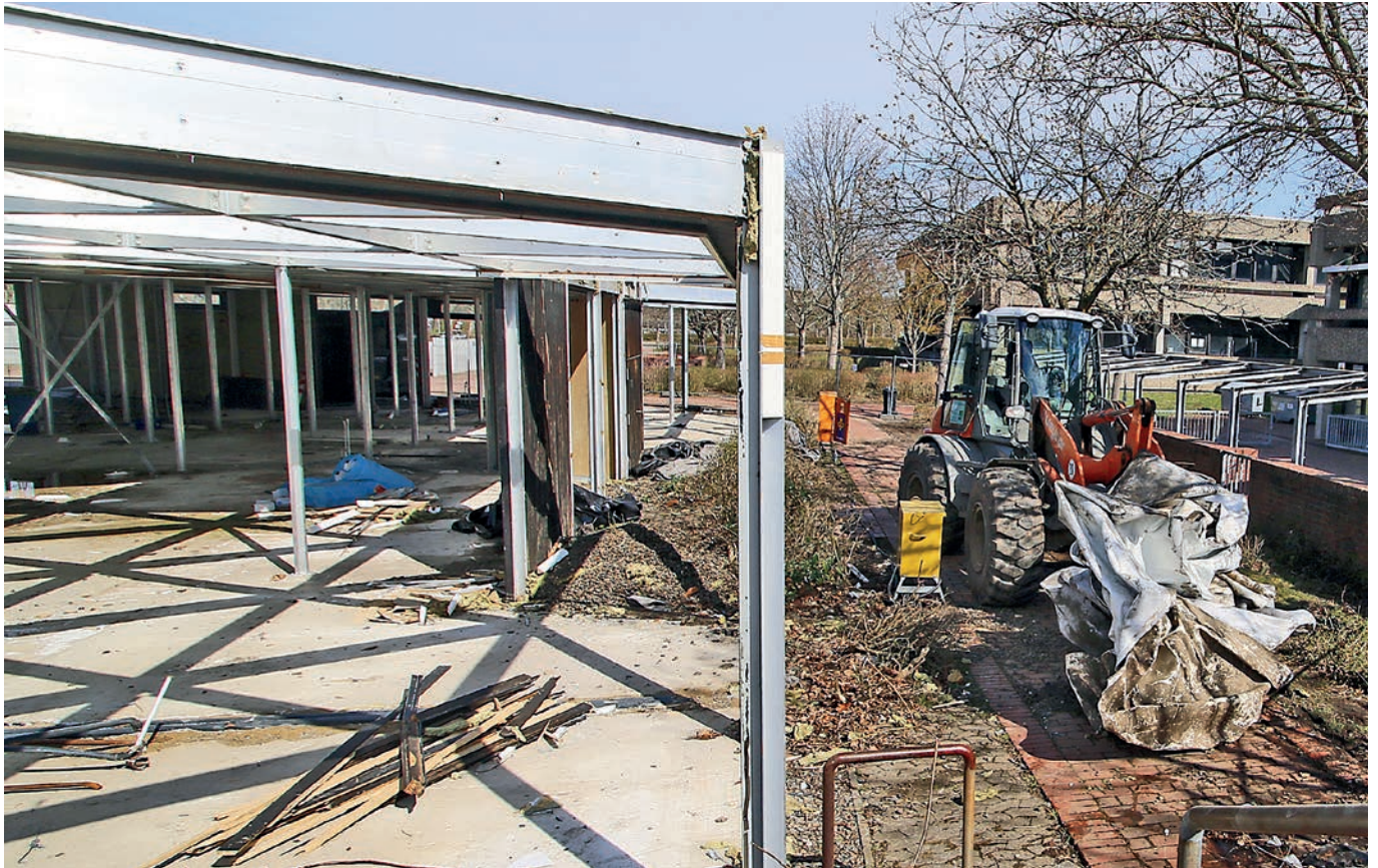
Abbrucharbeiten am Pavillon des Christian-von-Dohm- Gymnasiums 2022 (Foto: Uwe Epping / GZ)
