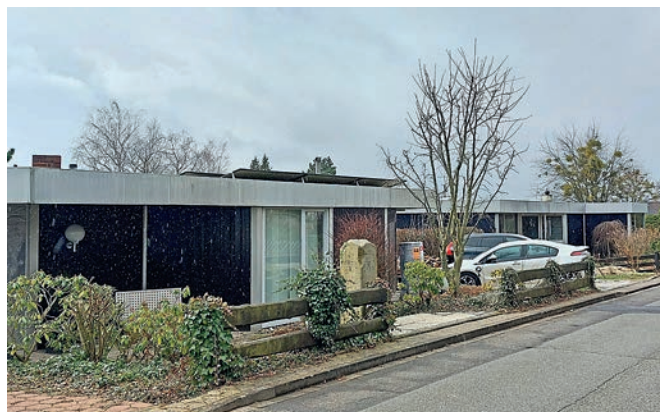
Trelement-Bungalows, Am Grauhöfer Holz in Hahndorf
