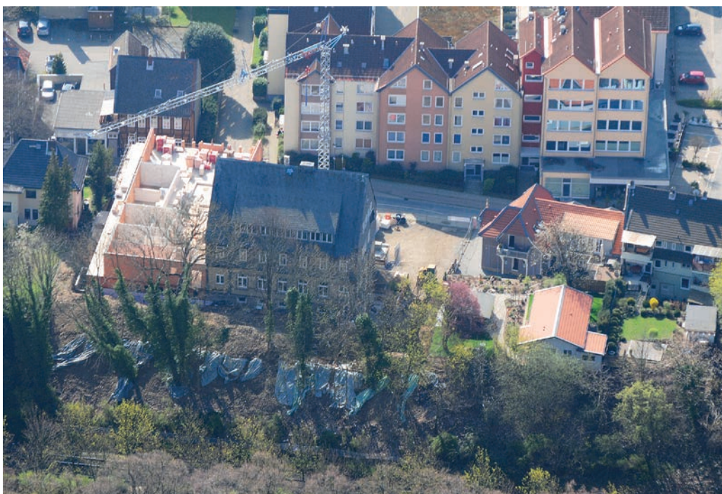
Baustelle Villa Saxer April 2017 mit verschiedenen Eingriffen in den Wall
