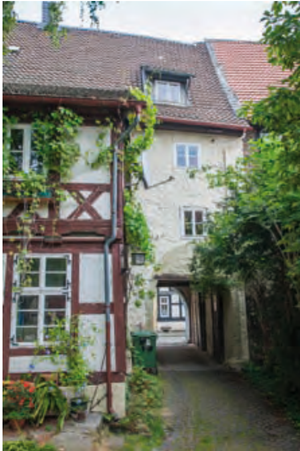
Abb. 175: Westansicht des Hauses mit hofseitigem Dielenportal.
