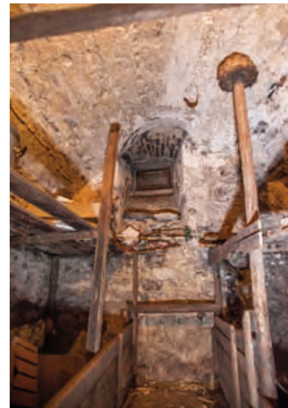
Abb. 196: Kellerraum hinter dem Balkenkeller der Kemenate mit leicht spitzbogigem Tonnengewölbe.
