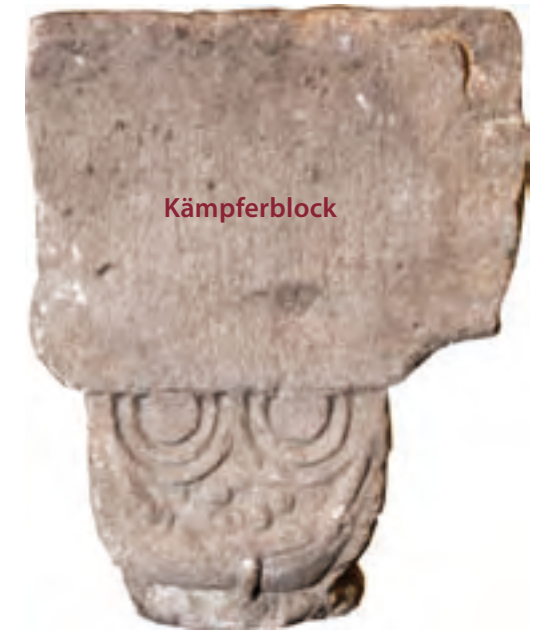
Abb. 26: Würfelkapitell mit ornamentierten Schilden, darüber Kämpferblock für das Bogenaufleger, vor/um 1200 (Kaiserpfalz, Lapidarium, vgl. Bergstraße 3).
