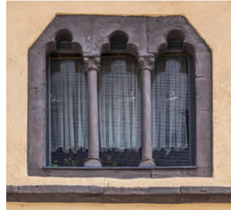
Abb. 161: Gewände eines vollständig in situ erhaltenen frühgotischen Drillingsfensters am Haus Schreiberstraße 2.
