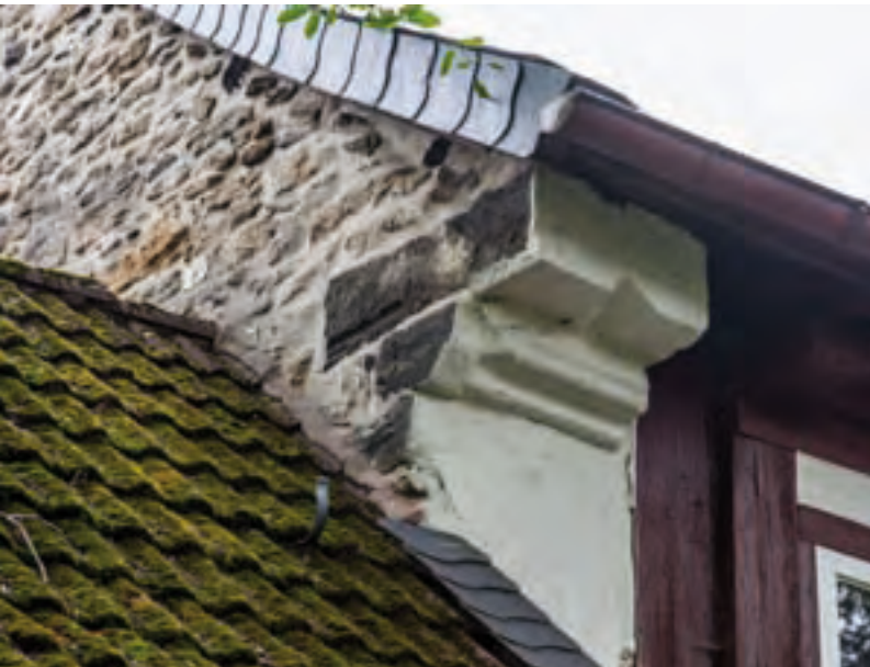
Abb. 190: Detail der Traufe des Nordgiebels mit zweitverwendeten Werkstücken ehemaliger Fenstergewände.
