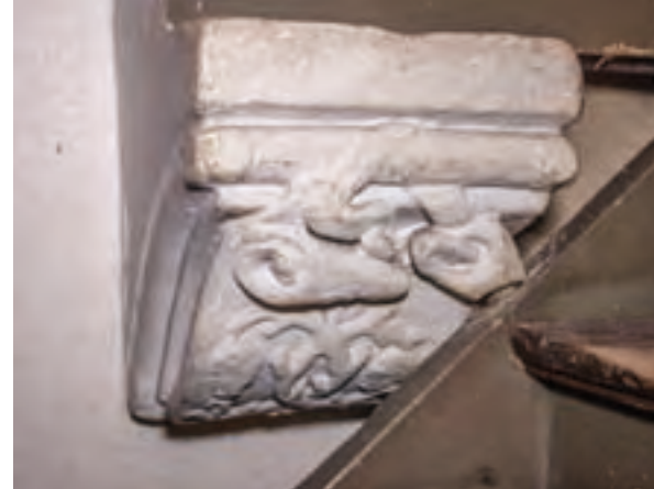
Abb. 208: Werksteinkonsole neben der Saaltür im Obergeschoss mit Wappendarstellung für das Auflager des Streichbalkens vor der Dielenwand des Wohnteils.
