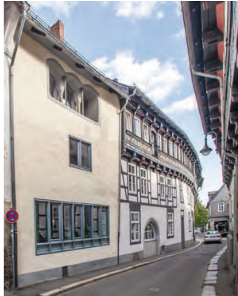
Abb. 136: Bergstraße 3, Südwestansicht der Straßenfront.
