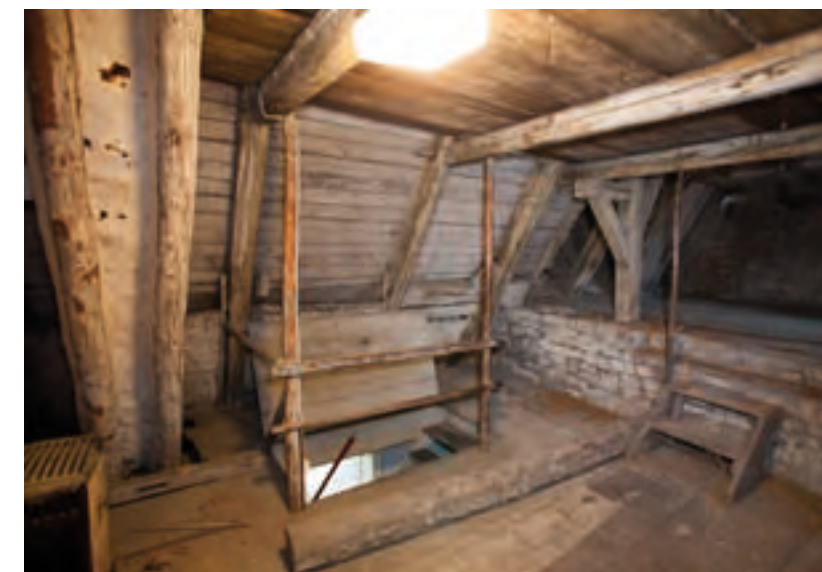
Abb. 220: Blick aus dem Dachbereich über dem ehemaligen Speicherstock nach Nordwesten in das höher liegende Dach über dem Saal. Der Mauerzug zeigt den oberen Abschluss der dielenseitigen Kemenatenwand.
