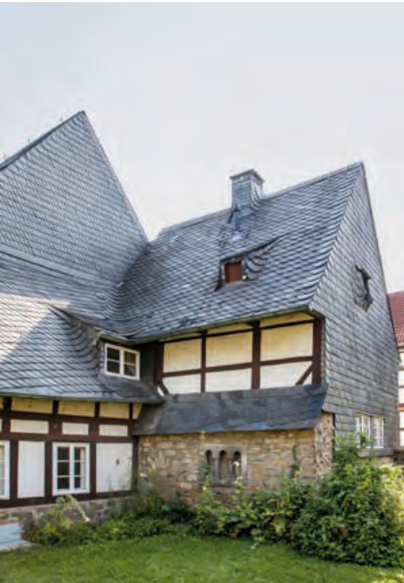
Abb. 99: Im Erdgeschoss des westlichen Gebäudeteils von St. Annen ist ein winkelförmiger Mauerzug aus Bruchsteinen erhalten. Es handelt sich um das Fragment eines hochmittelalterlichen Wohnbaus.
