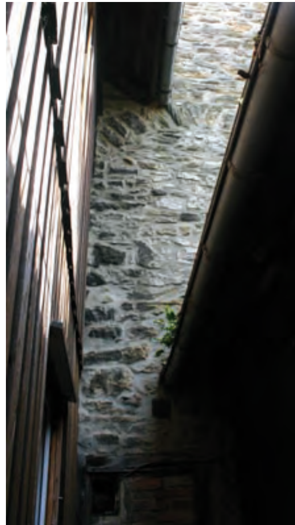
Abb. 191: Blick auf den Nordgiebel zwischen dem Haus Nr. 9 und dem nordwestlichen Anbau. Innerhalb des Giebelmauerwerks ist eine Öffnung mit Balkenzargen (unten) und ein Entlastungsbogen erkennbar.
