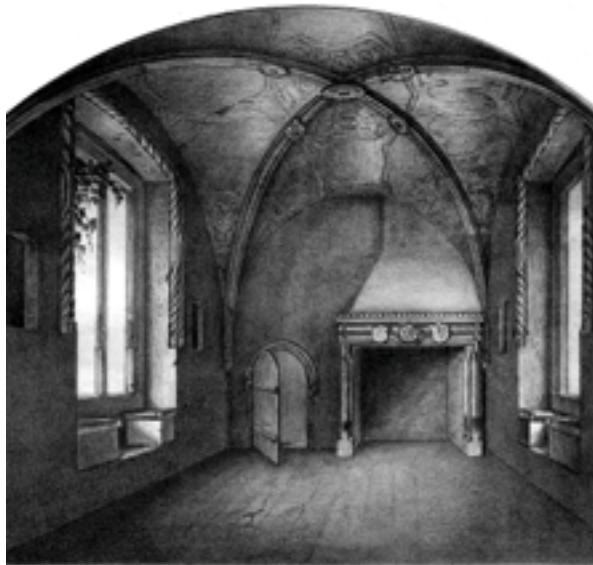
Abb. 43: Kemenate in der Münzstraße (Stadtbibliothek), Wohnraum mit Kreuzrippengewölbe und Kamin (Mithoff: Mittelalterliche Kunstwerke in Goslar, Hannover 1857, Tafel XXXIX ).
