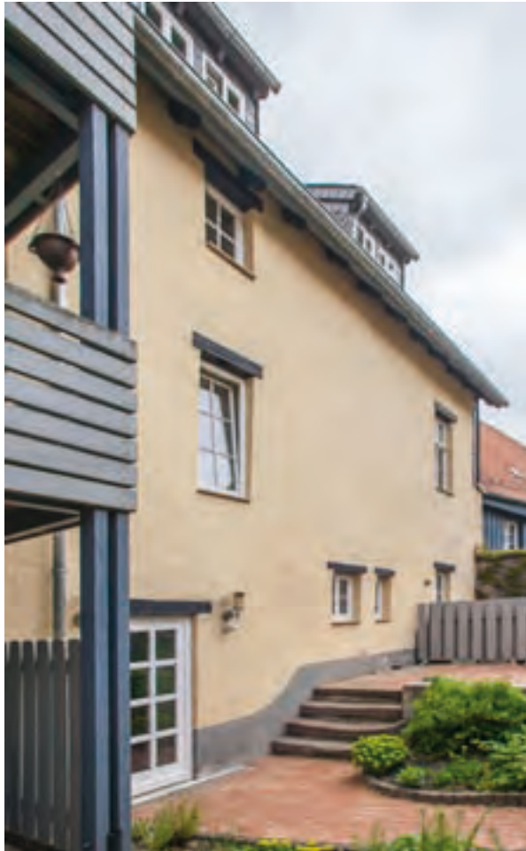
Abb. 163: Die Rückseite der Kemenate Schreiberstraße 2 zeigt Tür und Fensteröffnungen jüngerer Bauperioden.
