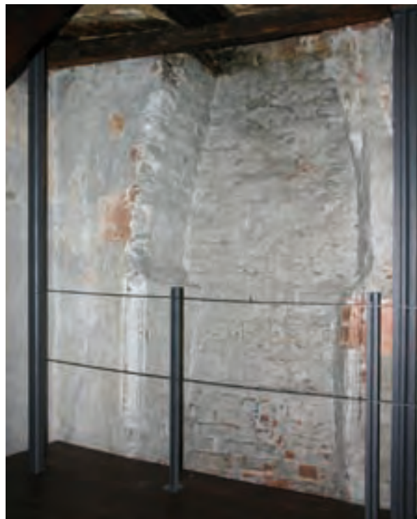
Abb. 113: Fragment der Kaminanlage in der Nordwand.
