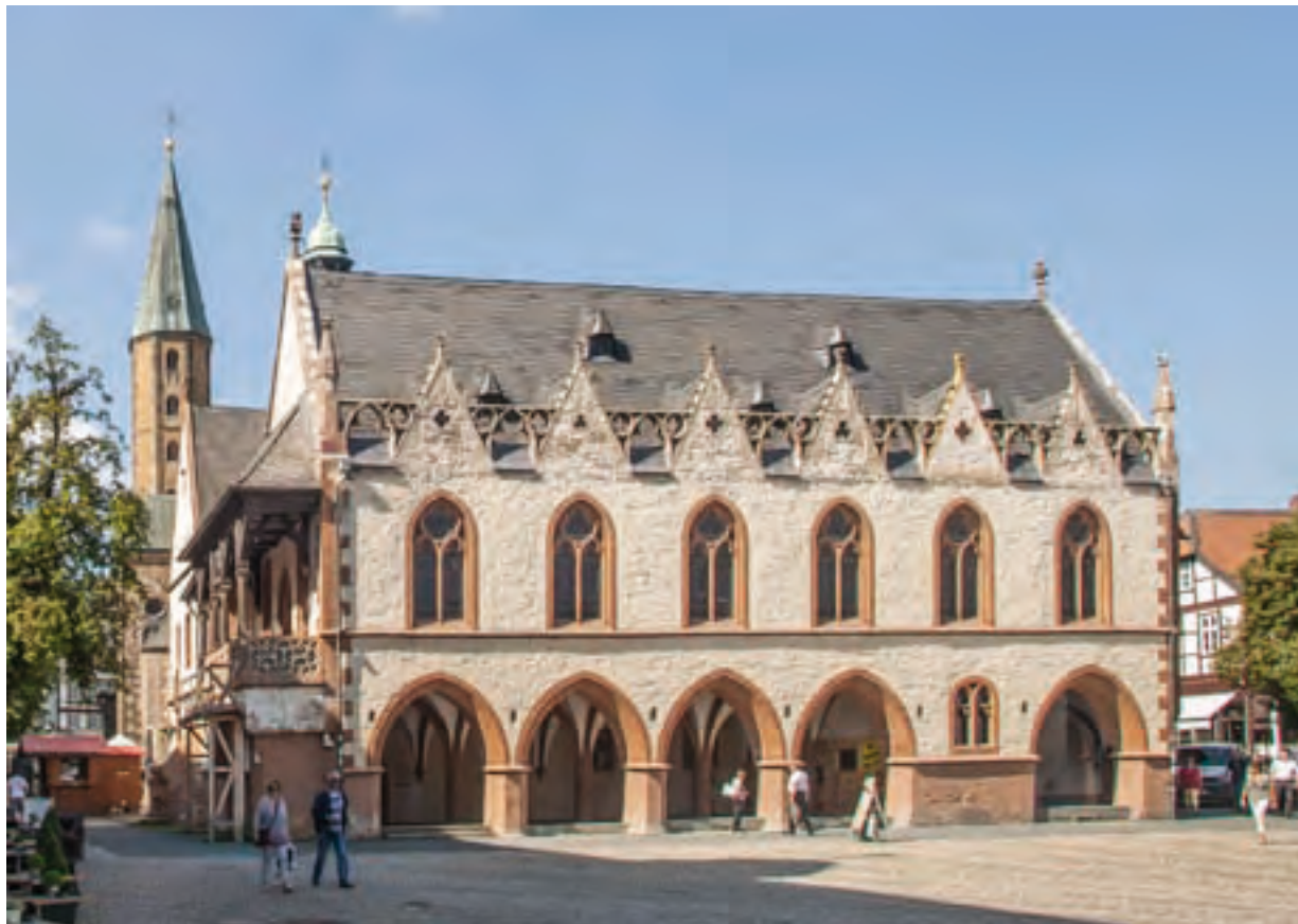
Abb. 54: Rathaus Goslar, Marktfront mit Erdgeschosslauben aus der Mitte des 15. Jahrhunderts. Die Spitzbogenfenster im Obergeschoss gehen auf eine Restaurierung des späten 19. Jahrhunderts zurück.
