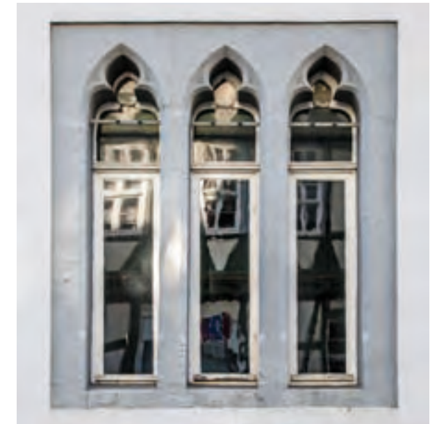
Abb. 130: Hochgotisches Drillingsfenster im Erdgeschoss.
