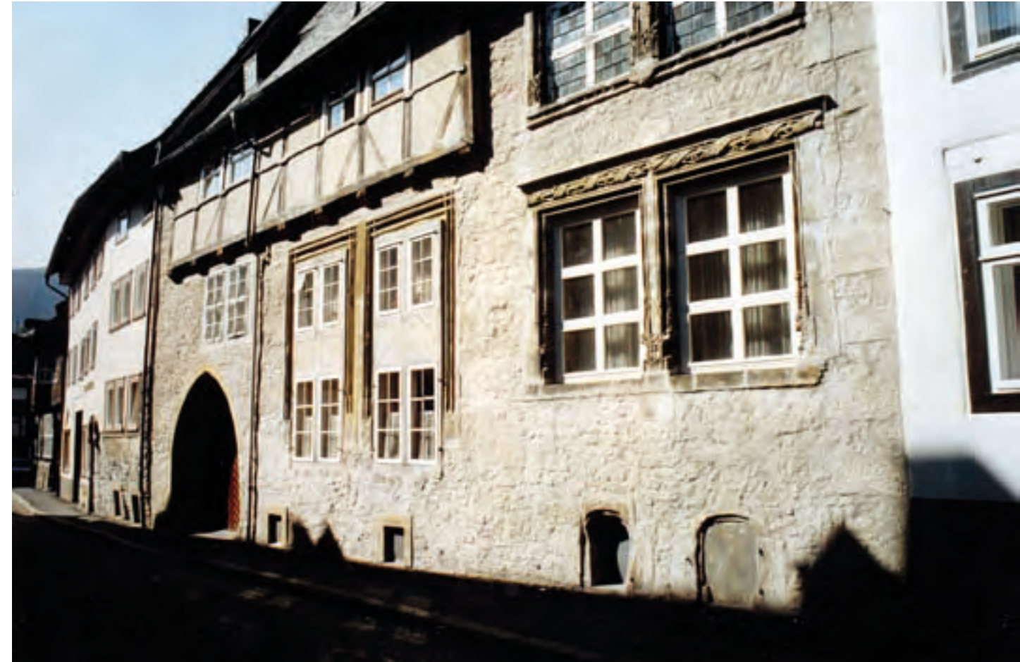
Abb. 245: Fassadenansicht während der Sanierungsarbeiten 1986, vor der Farbgestaltung.
