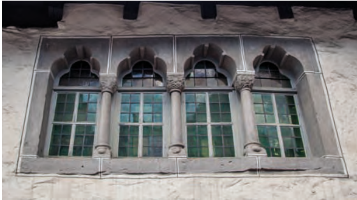
Abb. 27: Vierfach-Fenstergruppe aus dem frühen 13. Jahrhundert an der Kemenate des Großen Heiligen Kreuzes. Die in situ erhaltene Fensterarchitektur steht am Übergang von der Spätromanik zur Frühgotik. Sie zeigt reichverzierte Kapitelle, die Kleeblattbögenstürze sind mit Wülsten (sogenannten Nasen) versehen.
