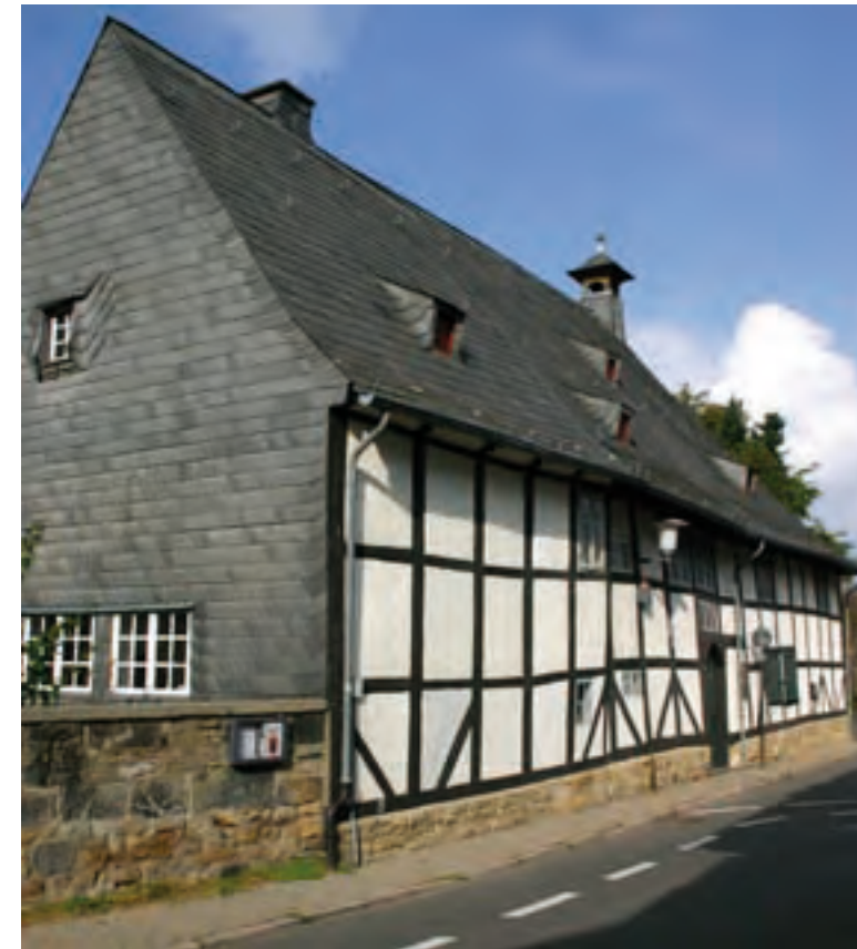
Abb. 97: St. Annenhaus, Glockengießerstraße 65. Blick auf die Straßenfronten von Dielenteil (rechts) und Küchenbereich (vorn). Die Fachwerkbauten stammen von um 1487.
