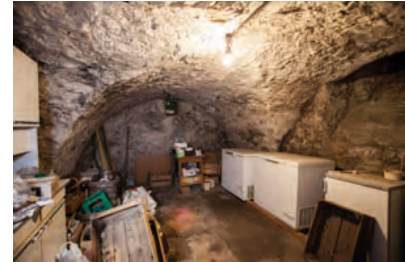
Abb. 197: Flaches Tonnengewölbe mit Stichkappen im Kellerraum hinter der Diele.
