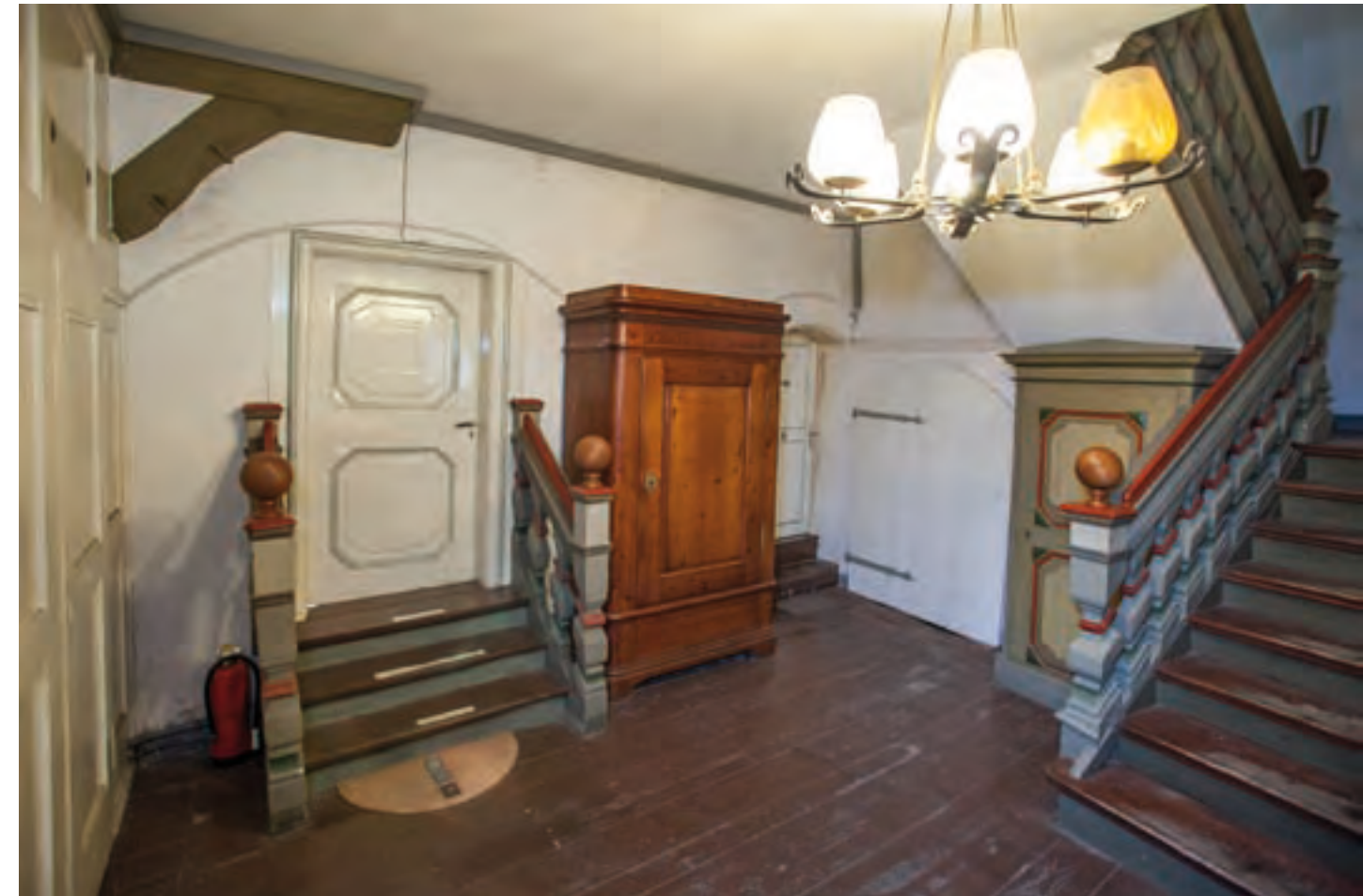
Abb. 199: Blick vom Eingang in der Hofdurchfahrt in den Dielenraum mit den barocken Treppenläufen. Die Treppengeländer weisen kräftige Baluster auf, die Kugelaufsätze über den An- bzw. Austrittsposten wurden in den 1950er Jahren nach Befund neu aufgesetzt. In der nordwestlichen Raumecke ist der Kellerhals sichtbar. Neben bzw. unter der Haupttreppe befindet sich ein begehbarer Wandschrank.
