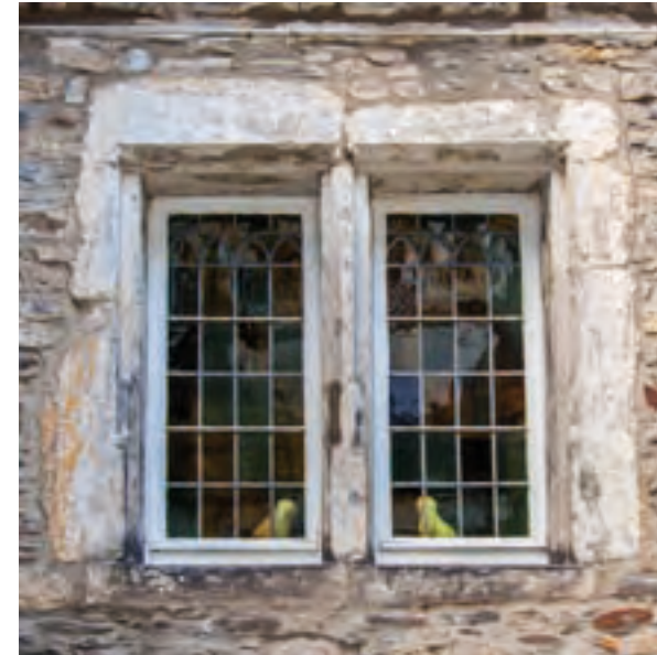
Abb. 127: Doppelfenster in der Ostwand der hofseitigen Kemenate.
