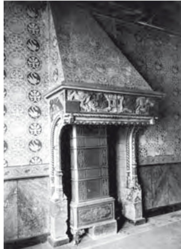
Abb. 244: Ansicht des Kamins in der Saalstube, um 1900.
