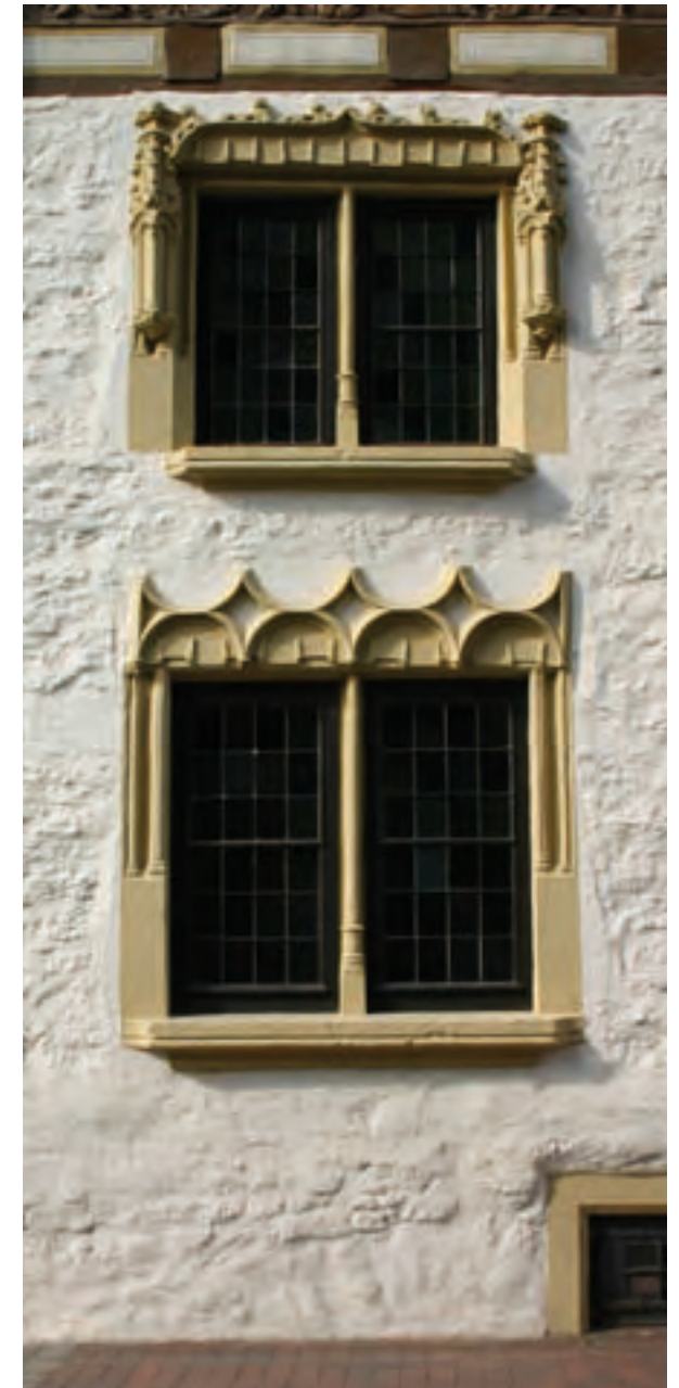
Abb. 66: Die Anordnung der Fenster im Südteil der Ostfassade dokumentiert den ursprünglichen Wohnteil des Brusttuches. Darunter: Kellerfenster des Tonnengewölbes.
