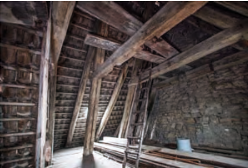
Abb. 223: Dachkonstruktion über dem Wohnteil. Im Vordergrund der Kehlbalken mit Anschlussbefunden (Blattsassen) für senkrecht ausgerichtete Hölzer.
