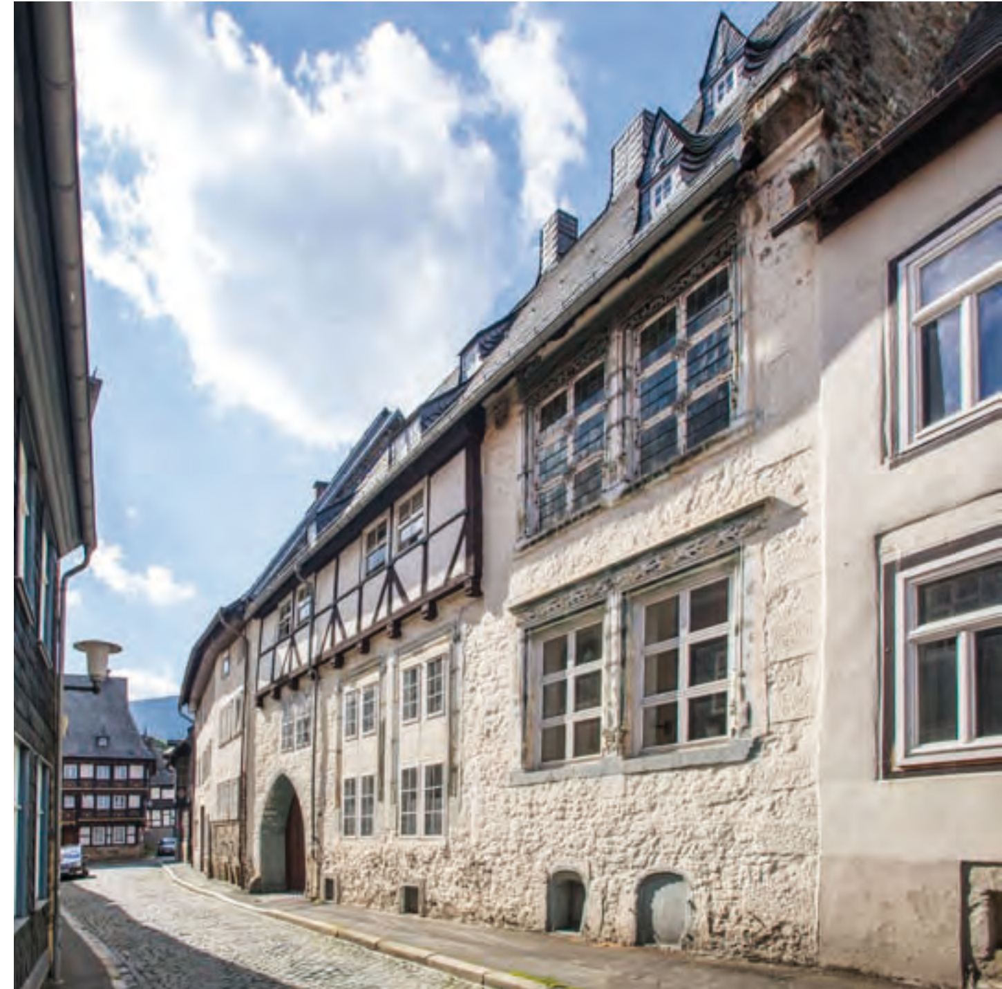
Abb. 170: Nordostansicht des Hauses Schreiberstraße 10 mit unterkellertem Wohnteil (rechts) und anschließendem Dielenteil mit Spitzbogenportal. Im Hintergrund: Einmündung Schreiberstraß/Bergstraße mit Magnus-Karsten-Haus.
