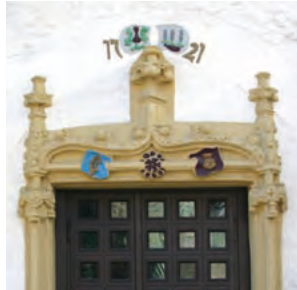
Abb. 60: Die heutige Gestalt des Portals an der Giebelfront geht auf eine Restaurierung von 1870 zurück. Der ursprüngliche Hauseingang zeichnet sich als schlichtes Spitzbogenportal ab. Im Scheitel befinden sich die Wappen der Erbauer und die Jahreszahl 1521. Die aufwändige Türrahmung ist hier in Zweitverwendung eingefügt und gehörte zu einer spätgotischen Kaminanlage.
