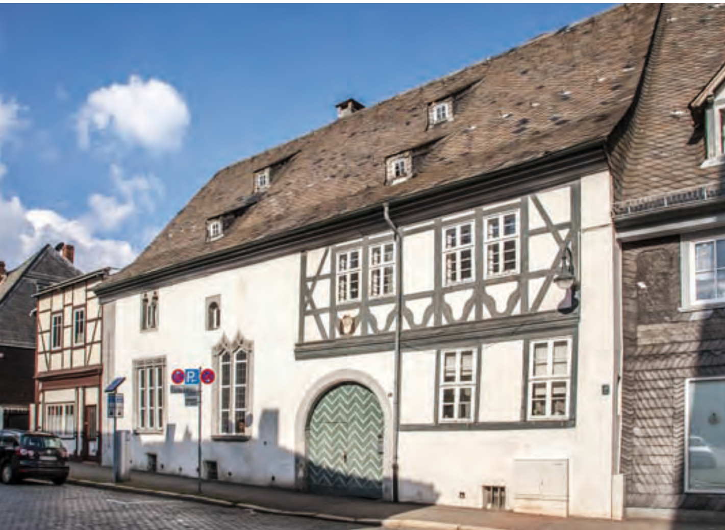
Abb. 116: Frankenbergerstraße 11, Südfassade mit steinernem Dielenteil (links) und Fachwerk-Wohnteil. Der wohl um 1700 erneuerte Wohnteil erstreckt sich auch über das Dielentor mit der Hofdurchfahrt.
