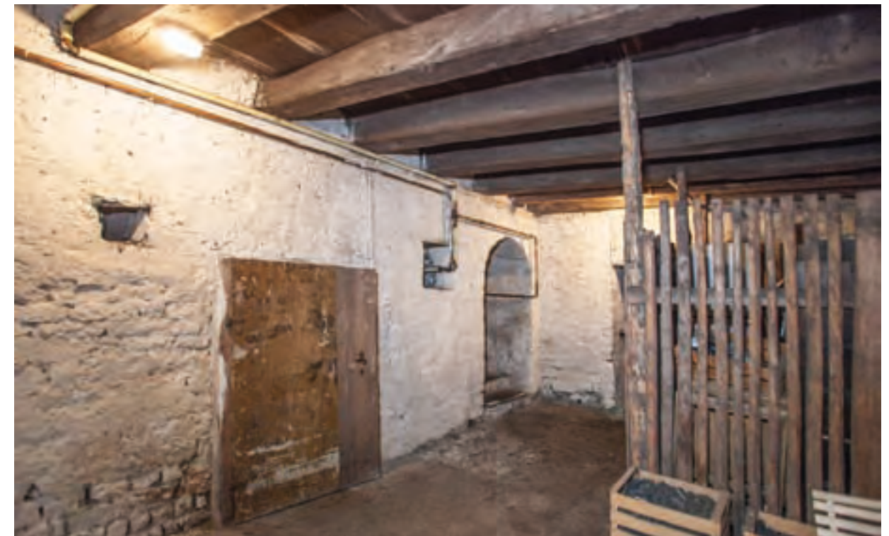
Abb. 193: Balkenkeller unter dem Wohnteil mit kernbauzeitlicher Rundbogenöffnung zum Treppenaufgang in das Erdgeschoss und nachträglicher Türostelle für den Zugang in den Gewölbekeller unter der Diele.
