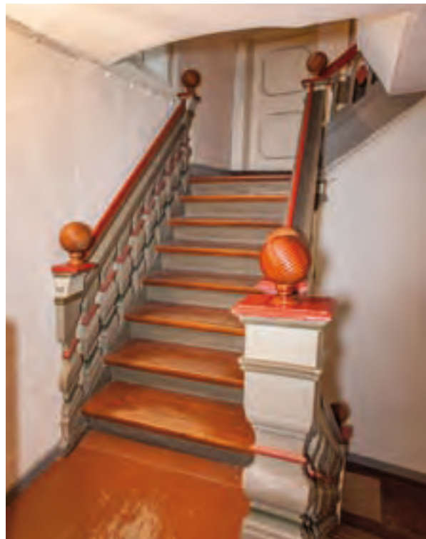
Abb. 206: Treppenlauf aus dem Zwischengeschoss zum Saal in der Kemenate und in das Obergeschoss des Dielenteils (ehemaliges Speicherstockwerk).
