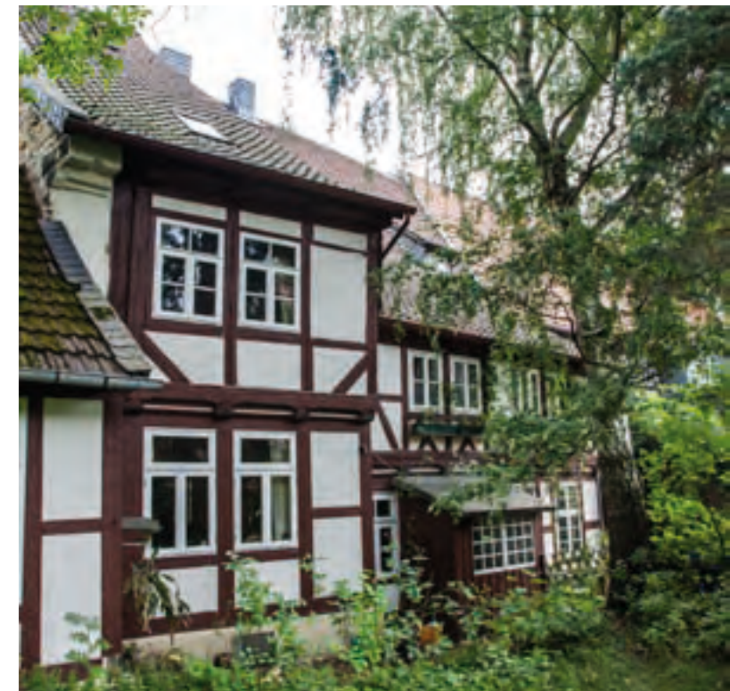
Abb. 189: Hofansicht mit den beiden um 1700 entstandenen Anbauten aus Fachwerk.
