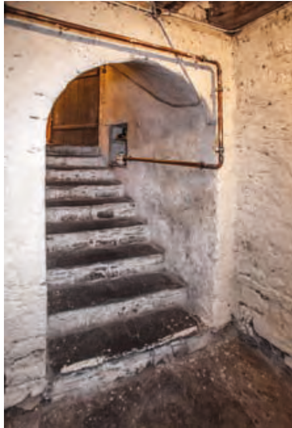
Abb. 194: Der Rundbogen zur Kellertreppe ist sauber in das umgebende Hausteinmauerwerk eingebunden.
