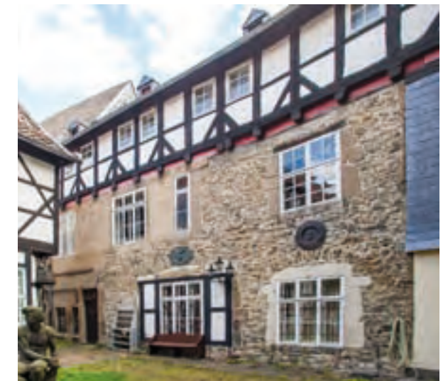
Abb. 49: Die Hofseite von Hoher Weg 5 zeigt den zweigeschossigen, spätgotischen Steinbau mit dem zugehörigen Fachwerkstock aus der Zeit um 1500. Im 1. Obergeschoss sind noch steinerne Fenstergewände sichtbar.
