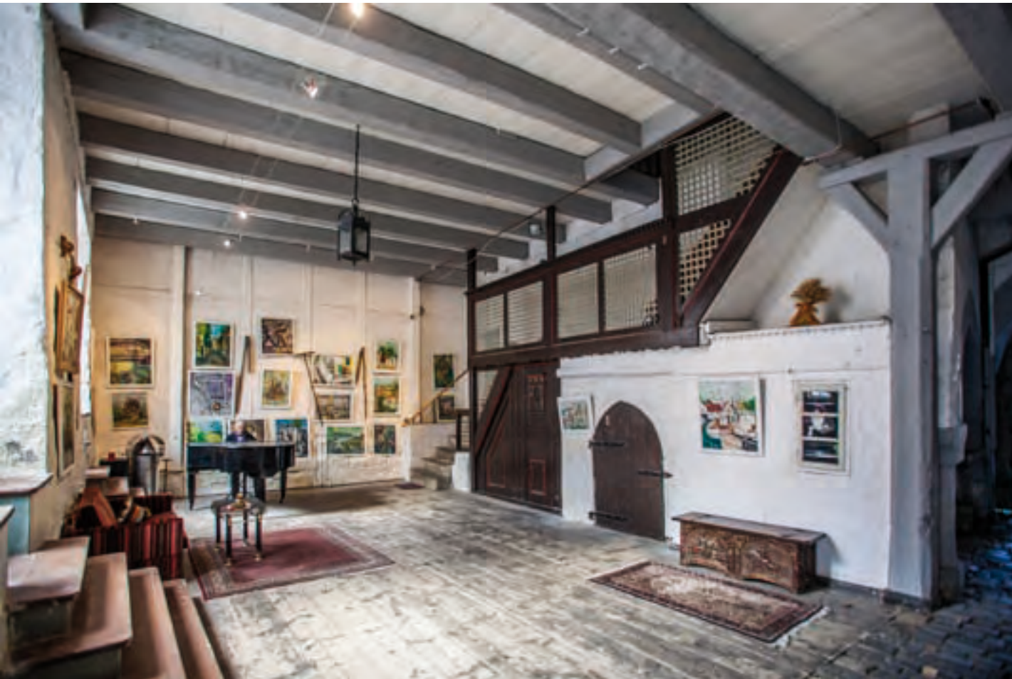
Abb. 119: Frankenberger Straße 11, Blick in die Diele nach Westen. In der Treppenwand befindet sich der Kellerabgang. Die Schmal- bzw. Giebelwand der Diele besteht aus Fachwerk (im Hintergrund sichtbar).
