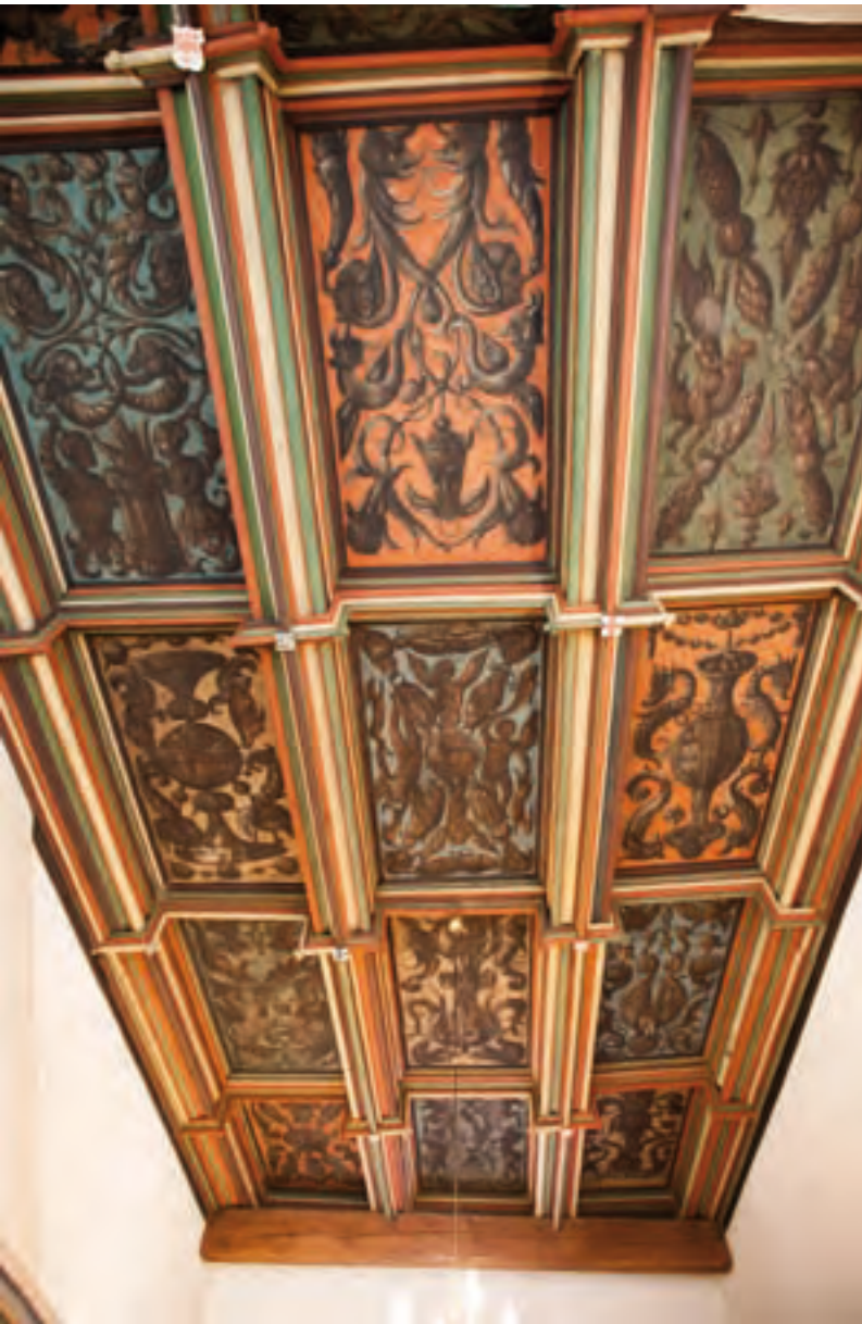
Abb. 214: Die mit Stabwerk profilierte Balkendecke ist durch quer verlaufende Gliederungen in rechteckige Felder aufgeteilt. Die getäfelten Felder tragen reich variierte Grotteskenmalereien.
