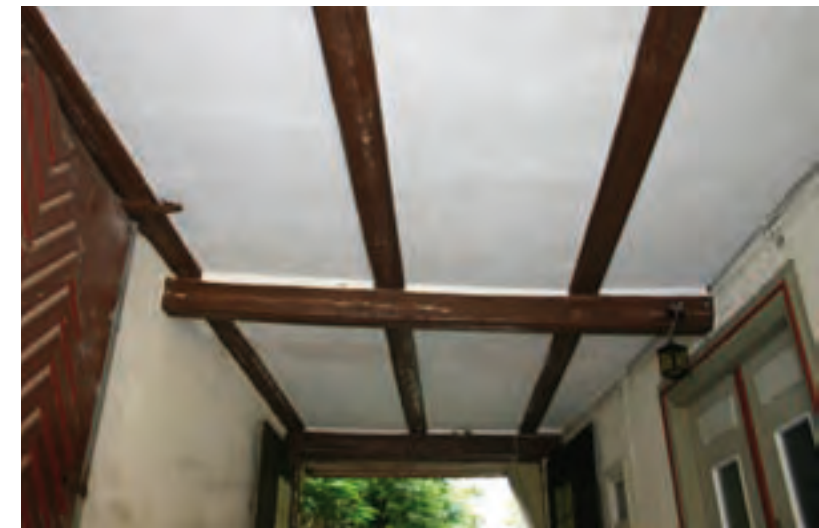
Abb. 238: Deckenuntersicht in der Durchfahrt mit profilierten Unterzügen und entsprechenden Deckenbalken.
