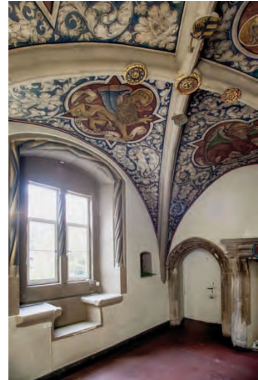
Abb. 75: Blick auf die westliche Fensterwand des Gewölberraums. Die Fensternische zeigt Sitzstufen und eine Rahmung mit Taustäben.
