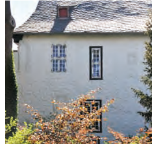
Abb. 106: Rosentorstraße 27, Ostteil der Nordfassade mit Fragmenten romanischer und frühgotischer Fensteröffnungen. Oben links: Fragment eines frühgotischen Drillingsfensters.
