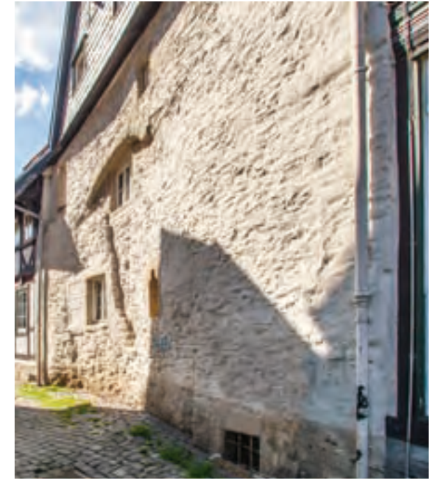
Abb. 29: Restbestand eines Steinhauses aus dem 13. Jahrhundert an der Amsdorfstraße 6 mit Kleeblattbogenfenster. An der Nordfassade zur Abzucht ist eine Fachwerkfassade aus dem 18. Jahrhundert vorgesetzt.
