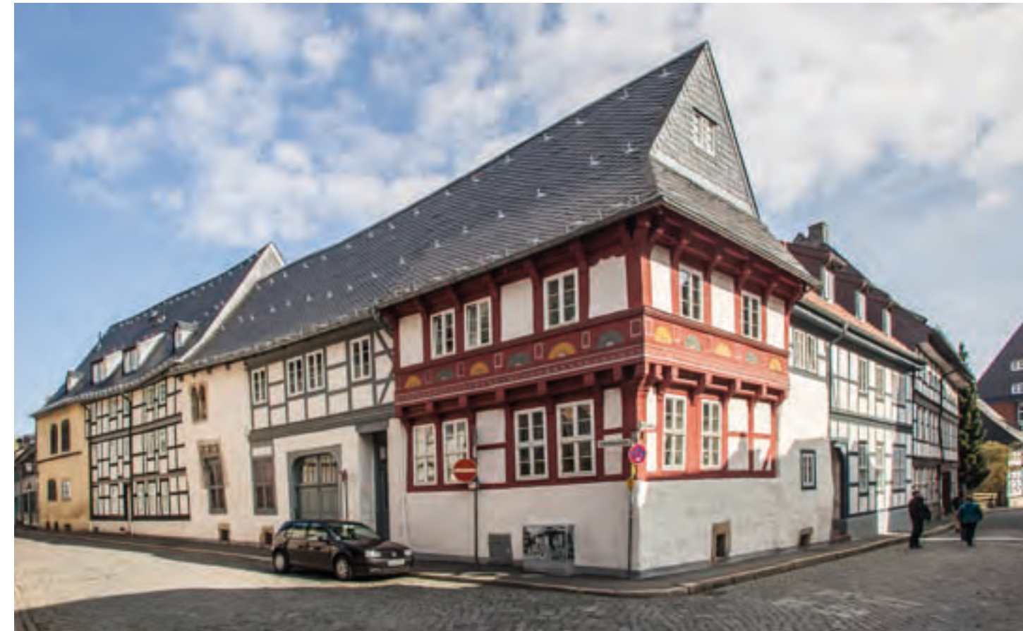
Abb. 149: Gesamtansicht der Häusergruppe Schreiberstraße 1 und 2 mit Blick in die Bergstraße (rechts). Die Hausnummer 1 umfasst die dreiteilige Bebauung unter dem lang durchgezogenen, einheitlichen Schieferdach. Blickfang ist der Fachwerk-Wohnteil aus der Renaissancezeit.
