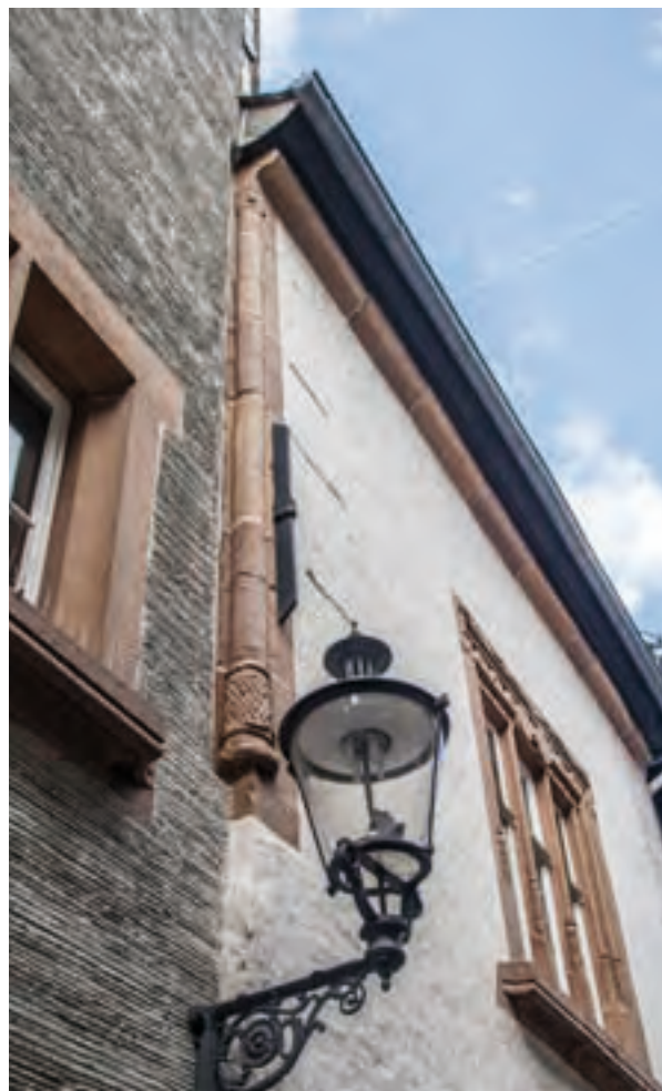
Abb. 71: Südostecke der Kemenate mit Betonung durch einen Rundstab.
