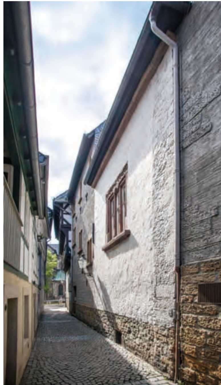
Abb. 67: Blick von Norden in die enge Münzstraße, rechts: die 1517 errichtete Kemenate. Das spätmittelalterliche Bauwerk ist an beiden Seiten von Gebäuden aus der Zeit um 1900 umbaut (ehem. Bibliothek und Archiv).
