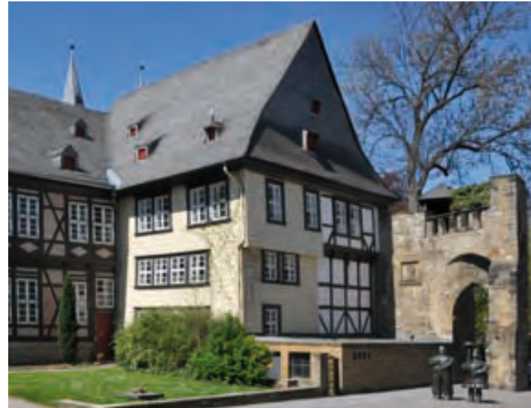
Abb. 105: Rosentorstraße 27. Der an die Stadtmauer anschließende Gebäudeteil birgt einen in mehreren Bauphasen entstandenen mittelalterlichen Wohnbau. Das Ostgiebelfachwerk stammt von um 1650, der links anschließende Barockfachwerkbau entstand 1719.
