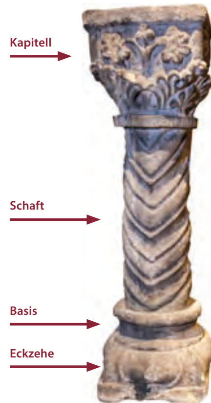
Abb. 24: Säule mit verziertem Schaft, attischer Basis mit Eckzeihen und Kapitell mit vegetabiler Ornamentierung in vager Anlehnung an die korinthische Ordnung, vor/um 1200 (Kaiserpfalz, Lapidarium).
