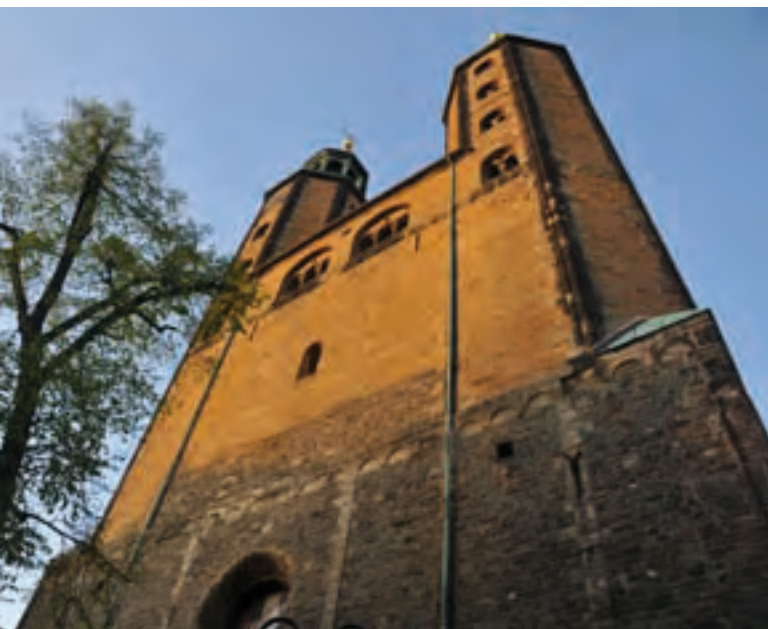
Abb. 21: Westbau der Marktkirche, im unteren Bereich bestehend aus dunkelgrauen Lese- und Bruchsteinen (u.a. Kahlebergquarzit); Türme und Glockenstube aus Sudmerberger Kalksandstein, Eckquader aus Hilssandstein.
