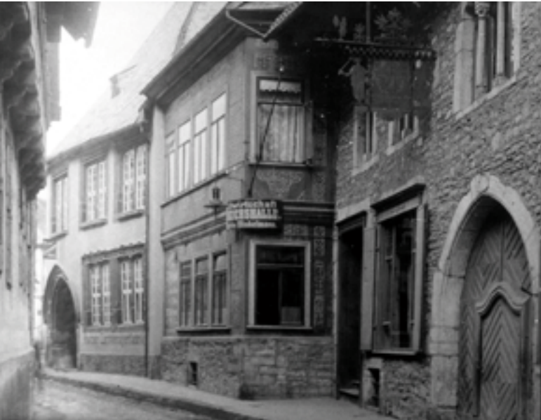
Abb. 30: Gotisches Dielentor des Hauses Bergstraße 4 (rechts, um 1250, 1913 abgebrannt; Stadtarchiv Goslar). Im Hintergrund das ebenfalls 1913 zerstörte spätgotische Haus Bergstraße 5.
