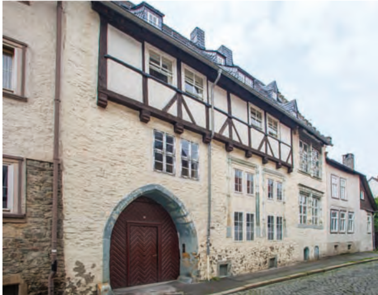
Abb. 173: Schreiberstraße 10, Blick auf die Straßenfront von Südosten.
