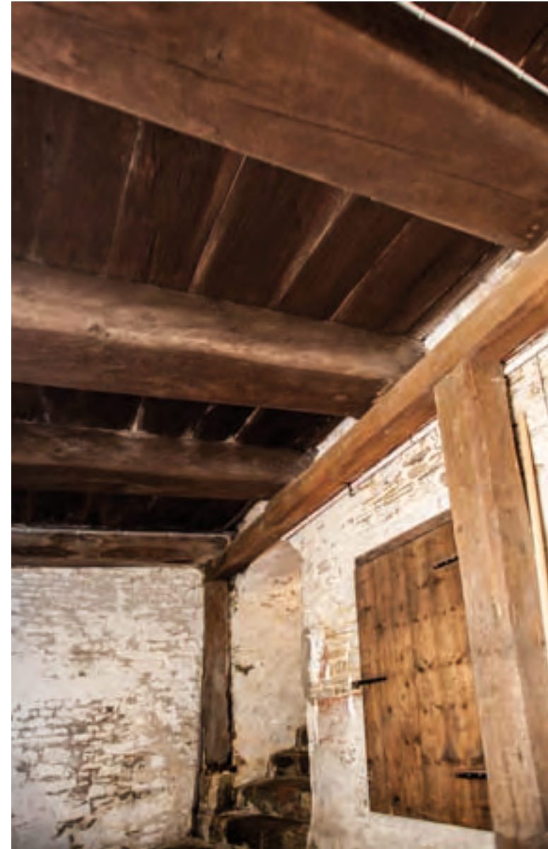
Abb. 160: Keller der Kemenate Schreiberstraße 2 mit mächtiger Balkendecke aus der Kernbauzeit um 1250. In der südöstlichen Raumecke ist der Treppenaufgang in das Erdgeschoss erkennbar (s. Abb. 164).
