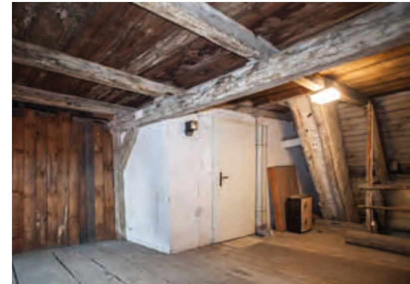
Abb. 219: Dachwerk, Blick in den Dachraum über dem ehemaligen Speicherstock. Das Sparrendach zeigt einen mittigen Stuhl, links: Stuhlständler mit Kopfband.
