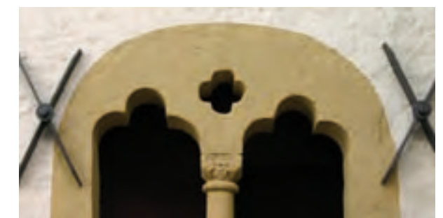
Abb. 63: Detail des Doppelfensters aus dem frühen 13. Jahrhundert mit Kleeblattbögen, Vierpass und Rankenkapitell mit Ringband.
