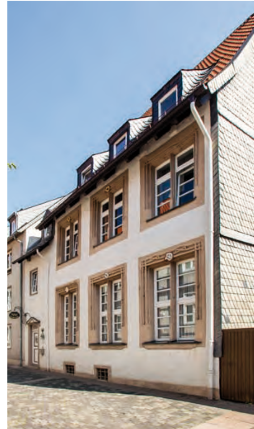
Abb. 78: Kemenate Worthstraße 7, Westfassade. An den verschieferten Giebel schloss der 1914 abgebrannte Dielenteil des Hauses an.
