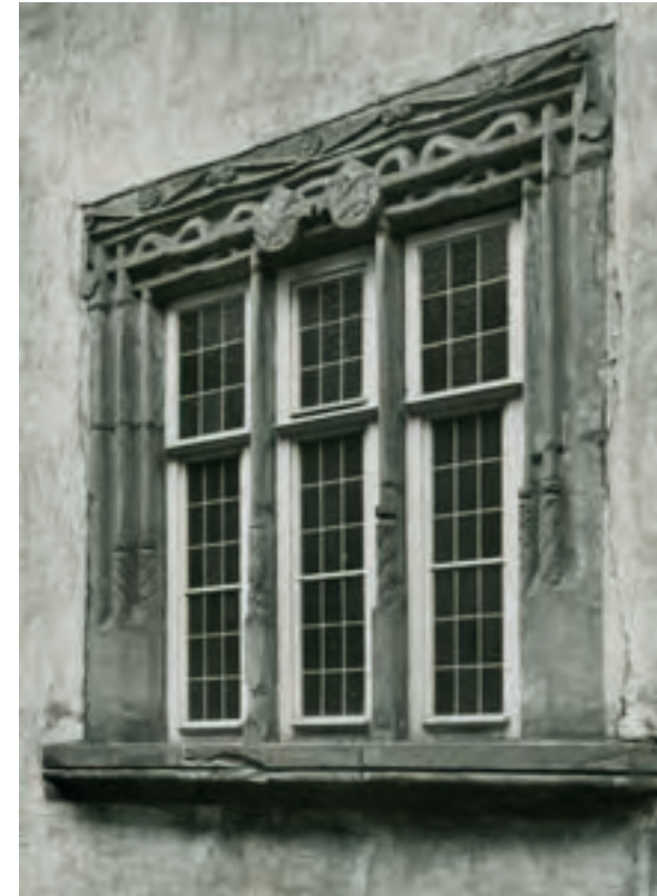
Abb. 72: Fensteröffnung in der Ostfassade der Kemenate Münzstraße, um 1940.
