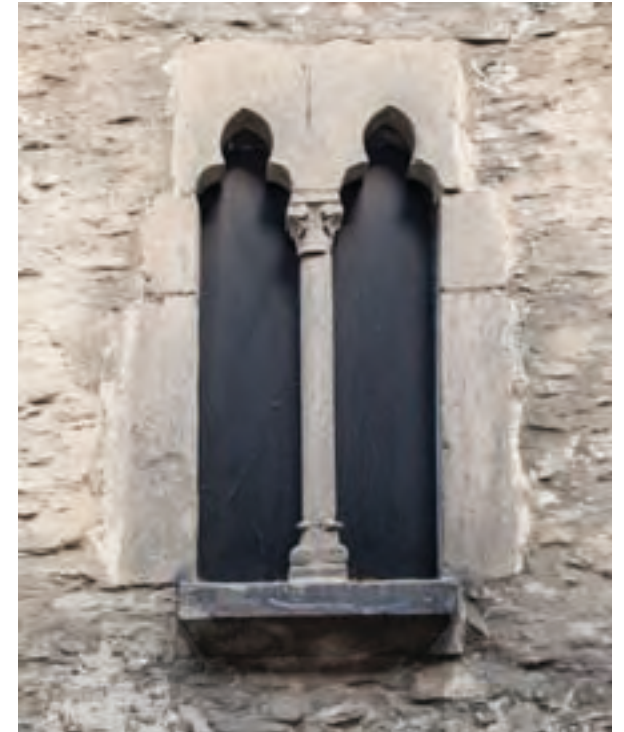
Abb. 32: Frühgotisches Doppelfenster am Haus Jakobstraße 11 mit Knospenkapitell. Als Säulenbasis ist ebenfalls ein Kapitell eingefügt - vermutliche Zweitverwendung der Fensterarkade im spätgotischen Gebäude.
