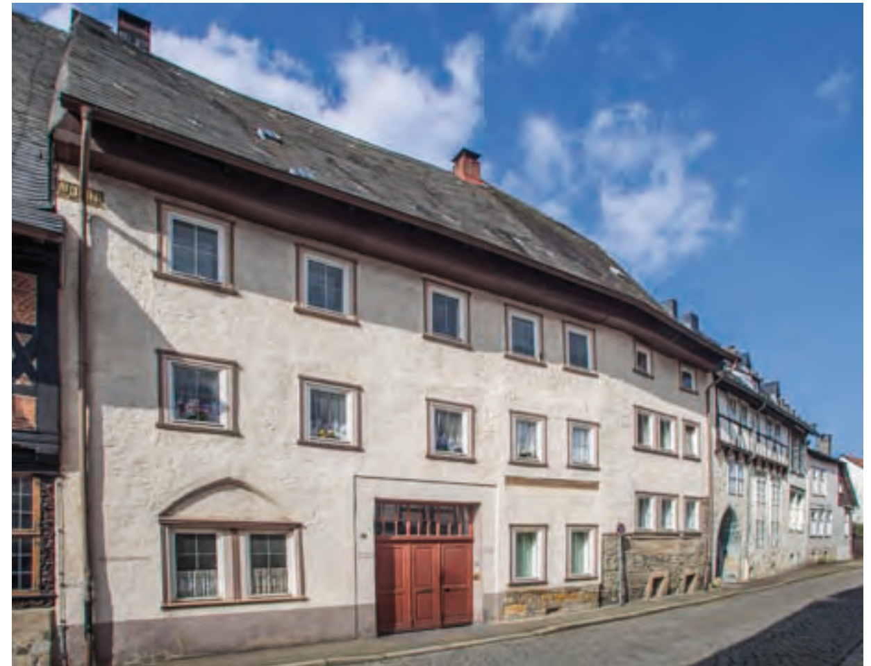
Abb. 165: Schreiberstraße 11, Ostfassade. Das hohe Alter des Hauses ist nur noch an Details wie dem vermauerten Spitzbogenportal und einem Inschriftbalken erkennbar. Rechts anschließend: Schreiberstraße 10 und 9.
