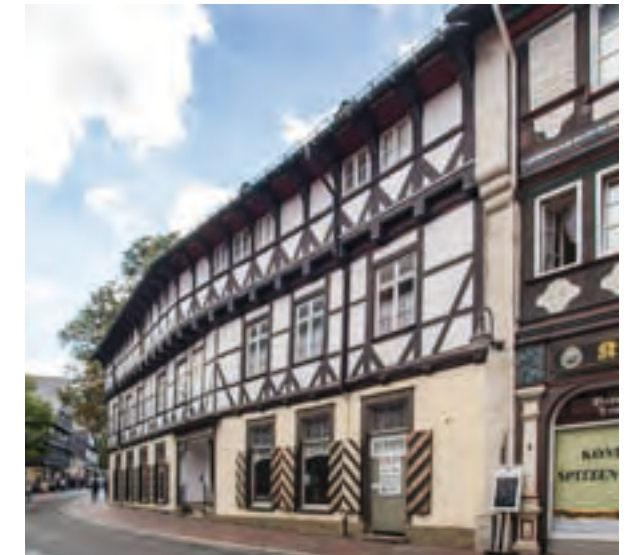
Abb. 48: Die Straßenfront des großen Hauses Hoher Weg 5 zeigt ein im 19. und 20. Jahrhundert völlig überformtes Erdgeschoss, ein Obergeschoss mit Fachwerk des 17. Jahrhunderts und ein weiteres Stockwerk mit einem gut erhaltenen Fachwerk aus der Zeit um 1500 (ehem. Speichergeschoss). Erd- und 1. Obergeschoss waren ursprünglich steinern, vgl. Hofseite.
