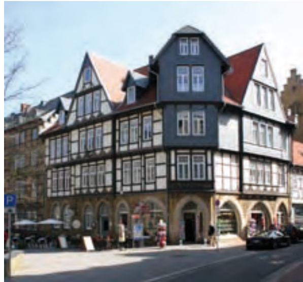
Abb. 83: Nach dem Brand entstand ein Wohn- und Geschäftshaus in historischer Interpretation der Formensprache Goslarer Bürgerhäuser.
