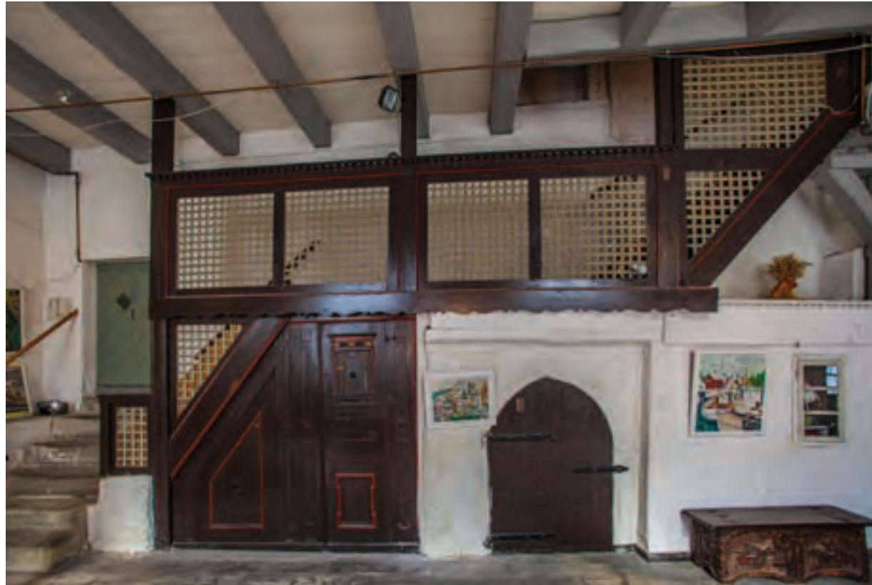
Abb. 121: Diele, Treppenaufgänge vor der nördlichen Dielenwand. Unter dem Treppenpodest der massive Kellerhals mit Spitzbogentür. Links: Zugang in das erhöht liegende Erdgeschoss des nordwestlichen Aanbaus (Kemenate).
