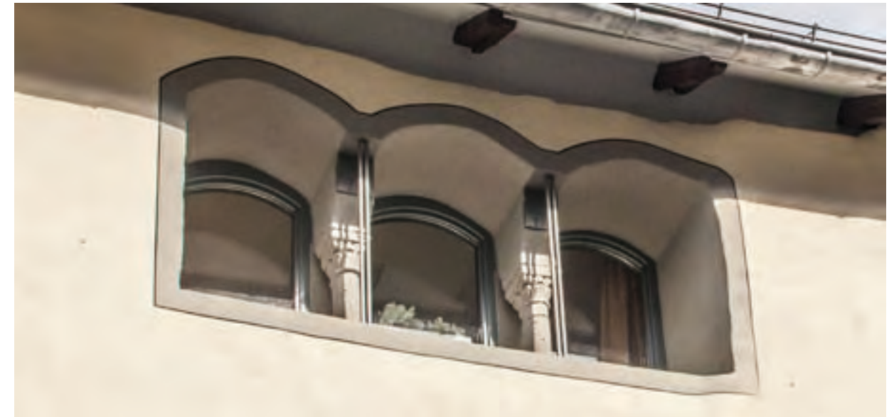
Abb. 137: Kemenate Bergstraße 3, Drillingsfenster im 2. Obergeschoss.
