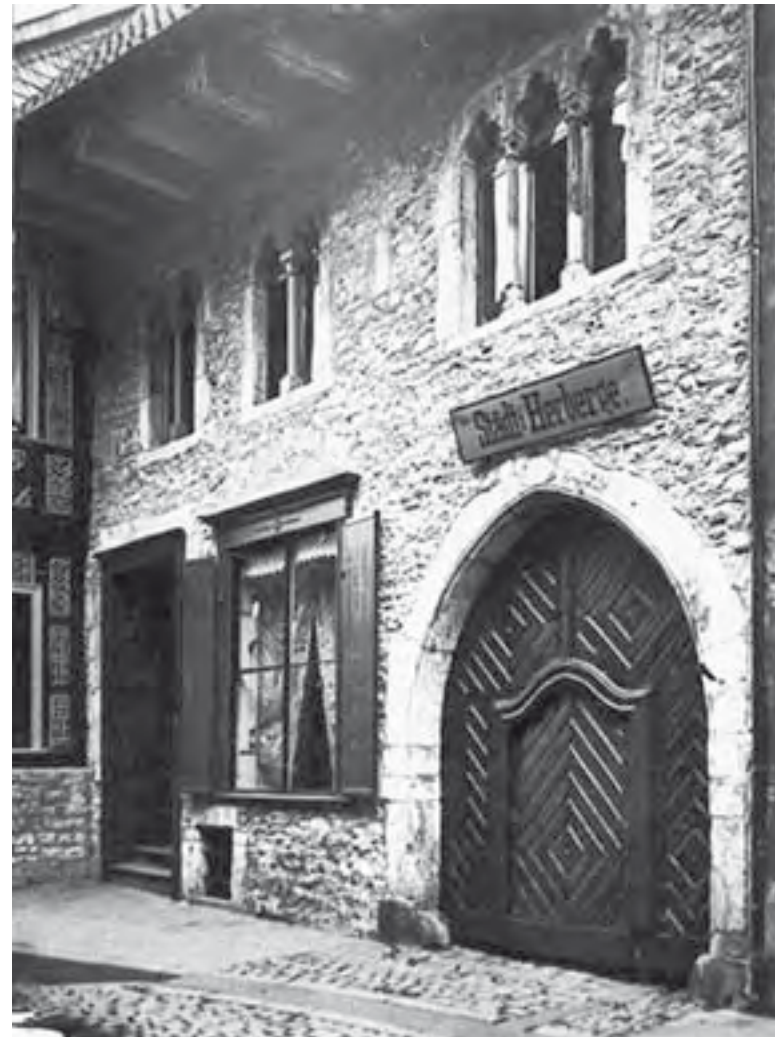
Abb. 139: Bergstraße 4, Straßenfront des Dielenteils vor dem Brand 1913 (Stadtarchiv Goslar). An Stelle des zweiten Eingangs und des Ladenfensters befanden sich Reste von spätgotischen Rechteckfenstern.
