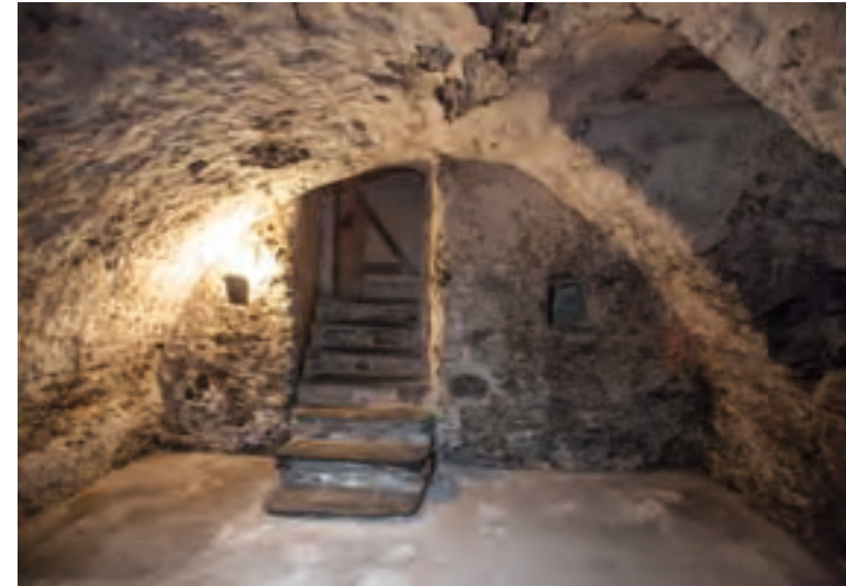
Abb. 195: Tonnengewölbe unterhalb der Diele.
