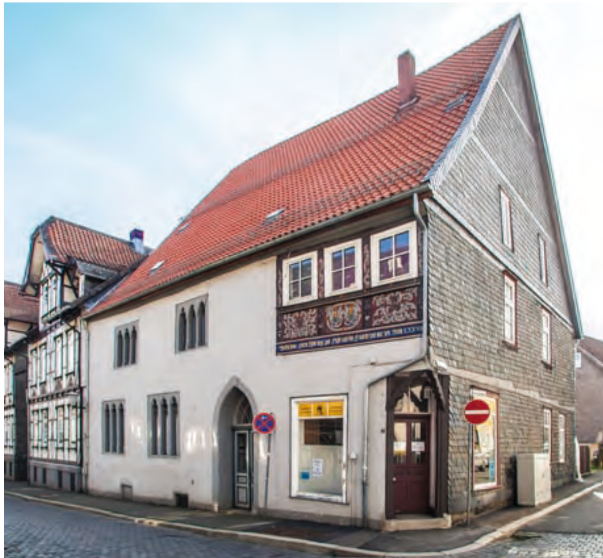
Abb. 129: Frankenberger Straße 23, Nordfassade.
