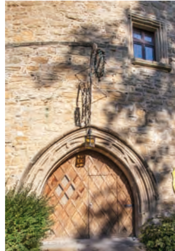
Abb. 143: Das spitzbogige Dielenportal von Bergstraße 5 ist, neben einigen Fenstergewänden (oben sichtbar) aus dem Haus, nach 1913 als neuer Eingang in den Dicken Zwinger wiederverwendet worden.
