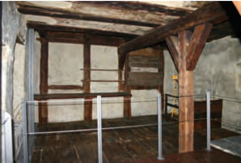
Abb. 111: Rosentorstraße 27, Zwischengeschoss mit Blick auf die Ostgiebelwand des Gebäudes aus Fachwerk von um 1650, vgl. Abb. 105. Aus der gleichen Zeit stammt der nachträgliche Unterzug.
