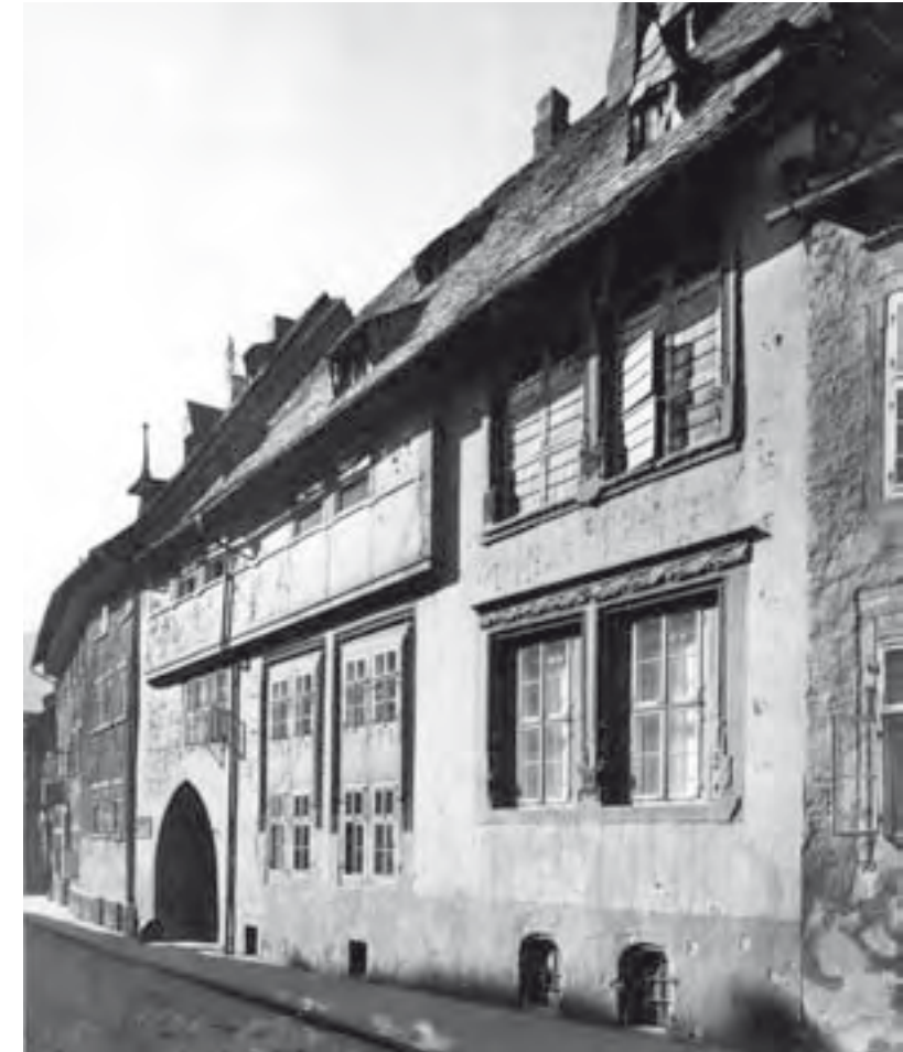
Abb. 174: Nordostansicht des Hauses Schreiberstraße 10 mit vollflächig verputzter Straßenfront, um 1930 (Archiv Wolfgang Korth).
