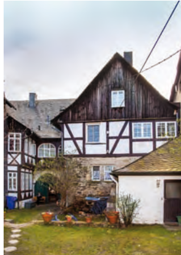
Abb. 126: Gesamtansicht der Hofseite von Frankenberger Straße 11 mit dem nordwestlichen Anbau (Kemenate, rechts) und dem Nordostflügel (links).
