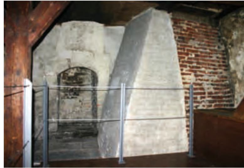
Abb. 112: In der südwestlichen Raumecke befindet sich der Rauchfang über der Feuerstelle im Erdgeschoss. Daneben befindet sich in der Längswand eine Kaminanlage.
