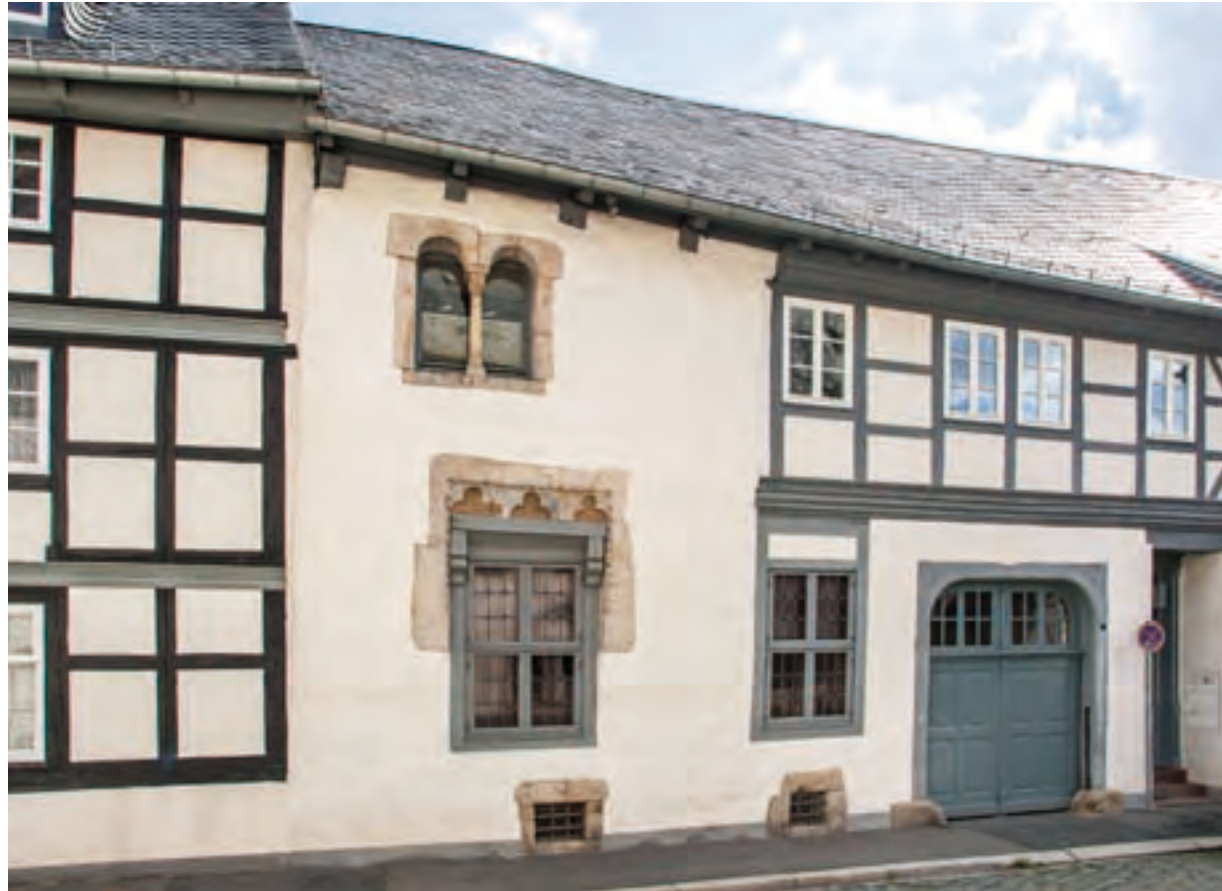
Abb. 150: Der steinerne Teil am Nordende der Straßenfront des Hauses Schreiberstraße stammt aus dem 13. Jahrhundert und gehörte ursprünglich wohl zum Dielenbereich dieses großen Massivbaus aus dem Hochmittelalter. Der Eingangsbereich des Dielenteils wurde im 18. Jahrhundert umgestaltet und erhielt dabei ein Fachwerk-Obergeschoss.
