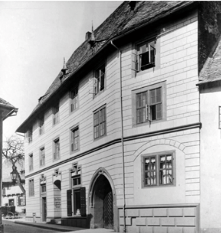
Abb. 37: Das dreigeschossige Steinhaus Bergstraße 6 („Ritter Ramm“) ist das größte erhaltene mittelalterliche Wohnhaus Goslars. Die Fassadengestaltung mit der Putz-Scheinquaderung stammt aus dem 19. Jahrhundert. Nach einem Brand (1979) blieben nur die Umfassungsmauern erhalten (Zustand um 1940, Stadtarchiv Goslar).
