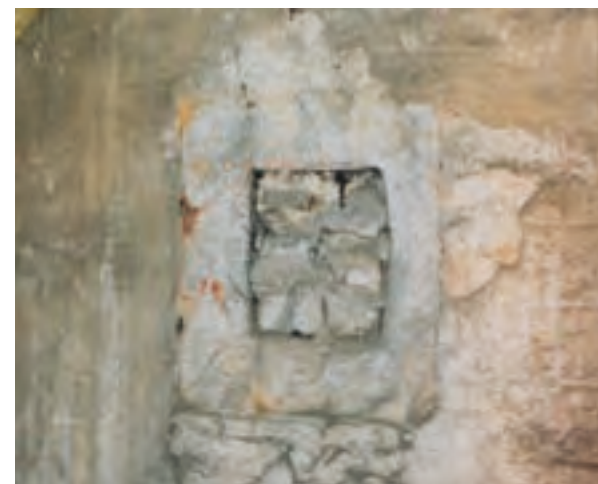
Abb. 225: Vermauerte Fensteröffnung im Nordgiebel, Ansicht von Norden aus dem Dachbereich von Schreiberstraße 9. Das Fenstergewände ist als Einsteifenster ausgebildet.
