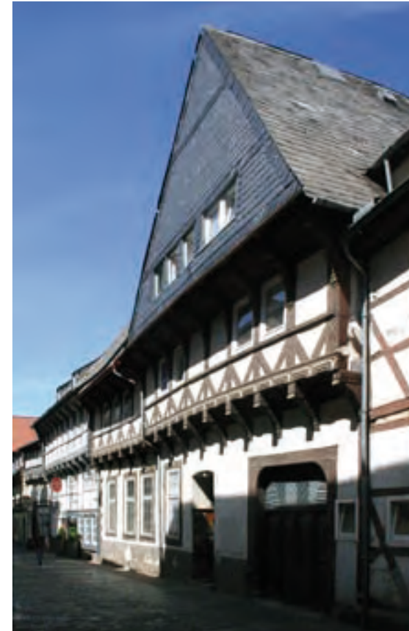
Abb. 12: Das Haus Worthstraße 9 mit steinernem Erdgeschoss und Fachwerkstock des frühen 16. Jahrhunderts. Über dem Dielenbereich erhebt sich ein steiler Giebel. In geschlossener Häuserzeile handelt es sich um eine Ausnahme in der von Traufenhäusern geprägten Stadt.
