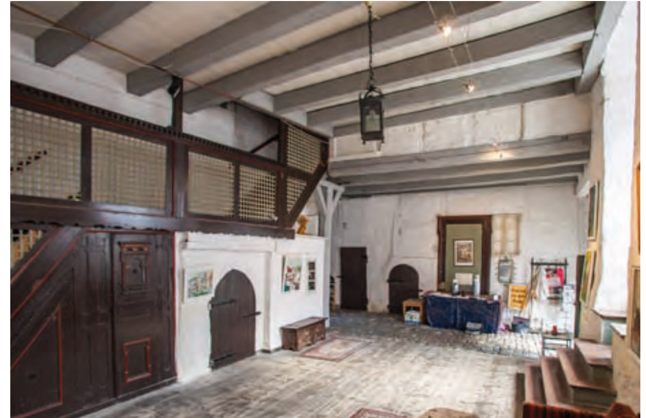
Abb. 120: Frankenberger Straße 11, Blick in die Diele nach Osten. Im Hintergrund die Fachwerkwand zum Wohnteil. Das Deckenniveau über der Hofdurchfahrt liegt niedriger - hier reicht das Obergeschoss des Wohnteils über die Diele.
