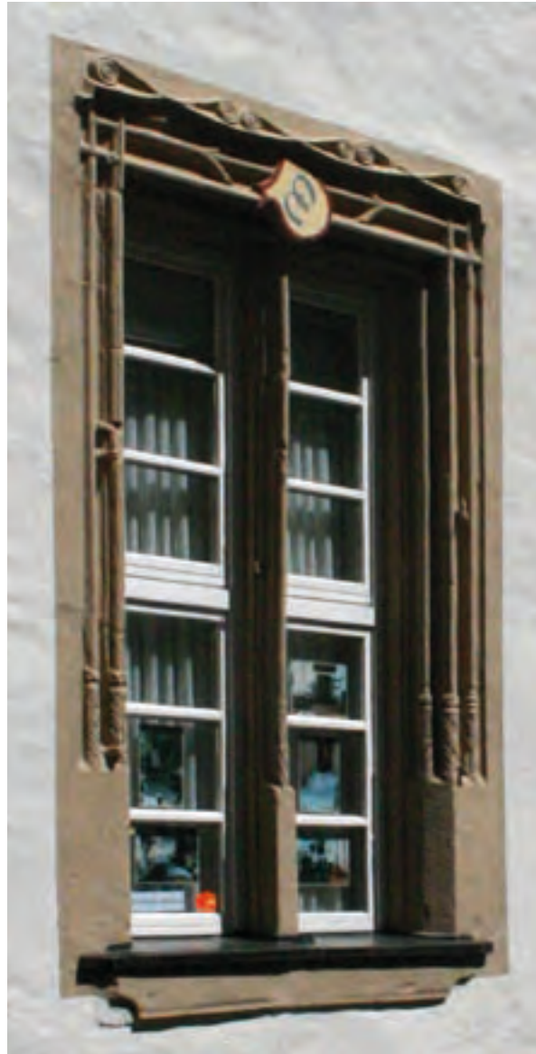
Abb. 79: Fensteröffnung im Erdgeschoss der Kemenate Worthstraße 7 mit reichen Stabwerkprofilierungen. Über dem Sturz zeigt sich eine Durchdringung von Stäben in Gestalt eines Vorhangbogens mit volutenartig eingerollten Enden..
