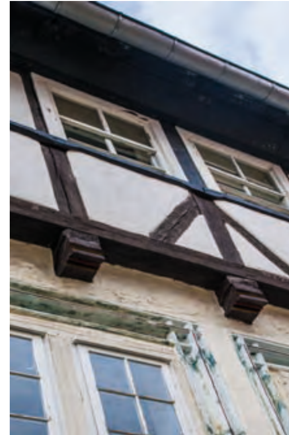
Abb. 177: Speichergeschoss, Detail der Auskragung mit Birnstab-Balkenköpfen. Sie waren zwischenzeitlich abgesehen und wurden 1986 mit ihren Profilen wieder ergänzt.
