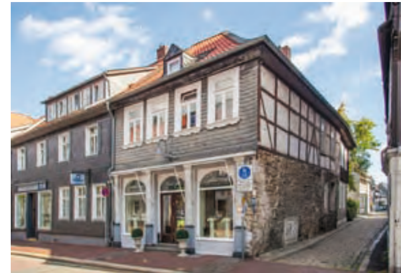
Abb. 132: Eckhaus Bäringerstraße 7 mit Fragment eines Steinbaus an der Seitenfront zur Schilderstraße.
