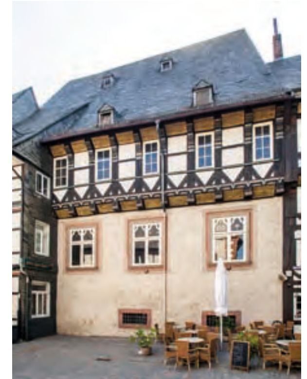
Abb. 53: Marktkirchhof 3, Steinhaus mit Fachwerkstock (um 1500). Die Fenster im Erdgeschoss sind in der Biedermeierzeit (um 1820-40) neugotisch umgestaltet worden.
