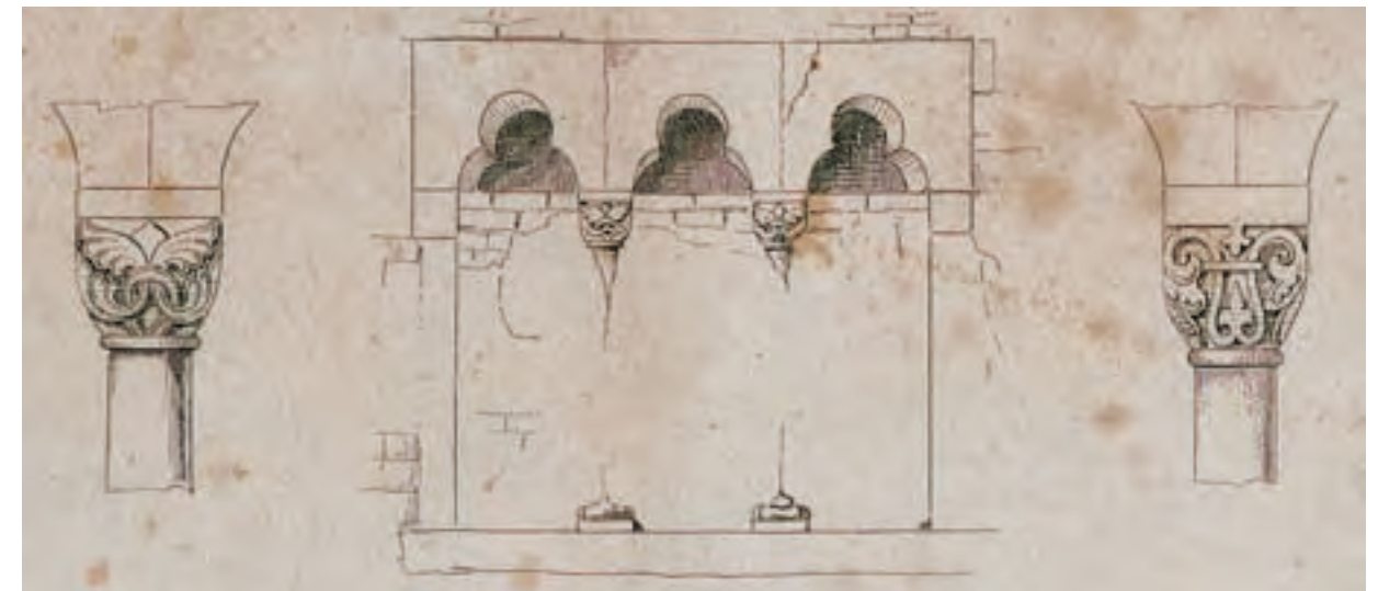
Abb. 103: Kornstraße 9, ehemalige Dreifenstergruppe von um 1225 an der Westfassade zur Rundenienstraße (Mithoff: Mittelalterliche Kunstwerke in Goslar, Hannover 1857, Tafel XXXI).
