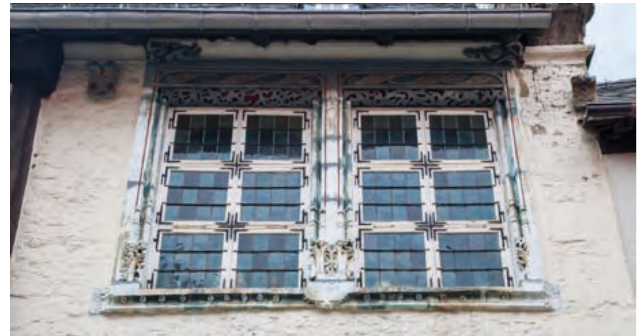
Abb. 182: Wohnteil (Kemenate), Fensteröffnungen im Obergeschoss mit Traufgesims und Drachenfiguren.
