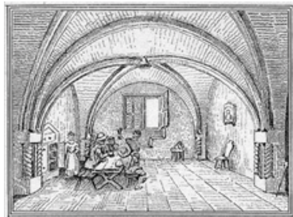
Abb. 146: Wohnteil im Westteil des Hauses Bergstraße 5, Gewölbe im Erdgeschoss. An der Rückwand befand sich der heute im Museum ausgestellte Kamin (Mithoff 1857, Tafel XXXIV).
