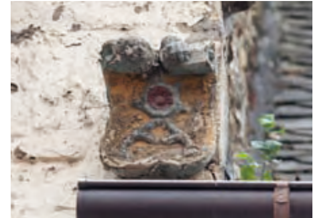
Abb. 188: Bisher unbekanntes Allianz-Wappen an der nordöstlichen Gebäudeecke. Die beiden Wappen an der Dachtraufe stammen von den kauern den Löwen des Saalkamins, vgl. Abb. 210. Die Tatzten stammen von den Kaminlöwen.
