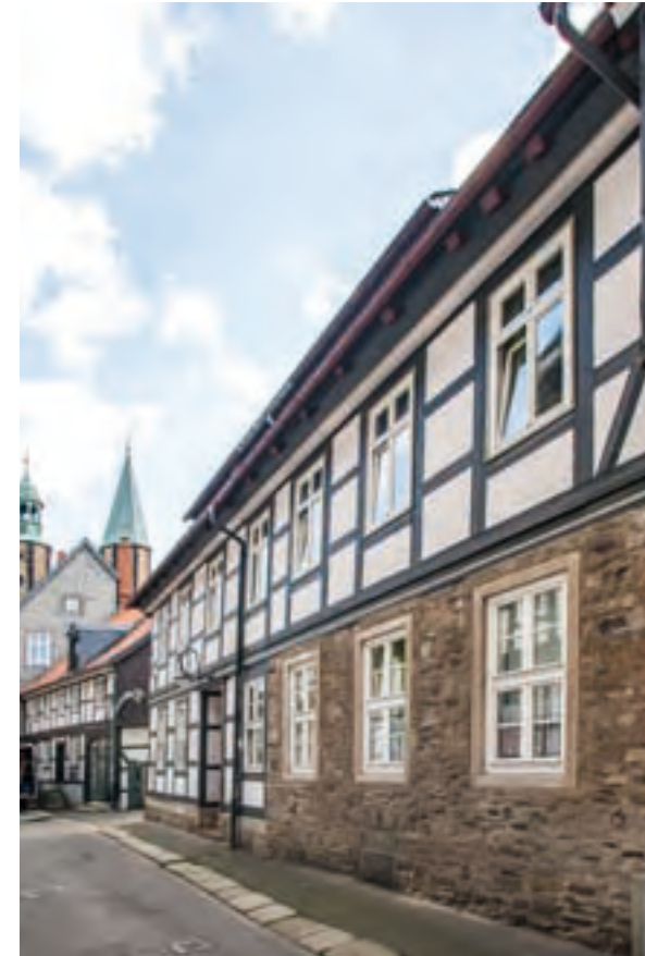
Abb. 41: Das Haus Bergstraße 62 weist auch im heutigen Bestand noch massive Gebäudeteile auf, zeigt sich aber weitgehend als Fachwerkbau der Zeit um 1800.
