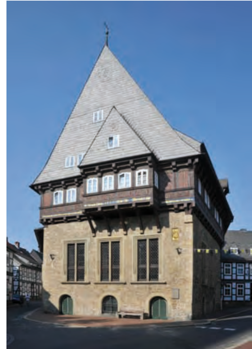
Abb. 55: Das Bäcker Gildehaus (Marktstraße 45) mit steinernen Unterbau von 1501 und Fachwerkaufbau von 1557 zeigt große Ähnlichkeit zu zeitgenössischen Wohnhäusern (vgl. Brusttuch), weist allerdings ein deutlich größeres Bauvolumen auf.
