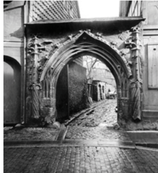
Abb. 40: Spätgotisches Portal Bergstraße 62, Aufstellung an der Hofzufahrt des Hauses (vor 1901, Stadtarchiv Goslar). Heute befindet sich diese wohl aufwändigste Portalarchitektur eines Goslarer Wohnbaus am Zugang in das Frankenberger Kloster.
