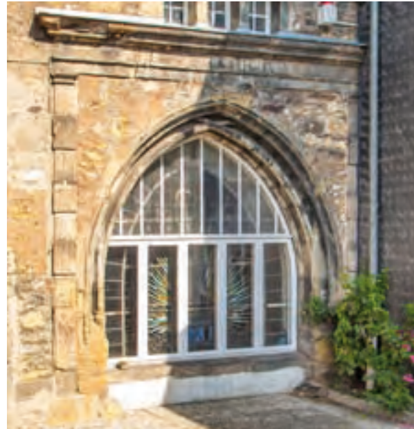
Abb. 51: Kornstraße 8, Spitzbogenportal mit Datierung 1501 an der Hoffassade. Die Rahmenarchitektur mit Pilastern und Gesims gehört zum Umbau von 1630.
