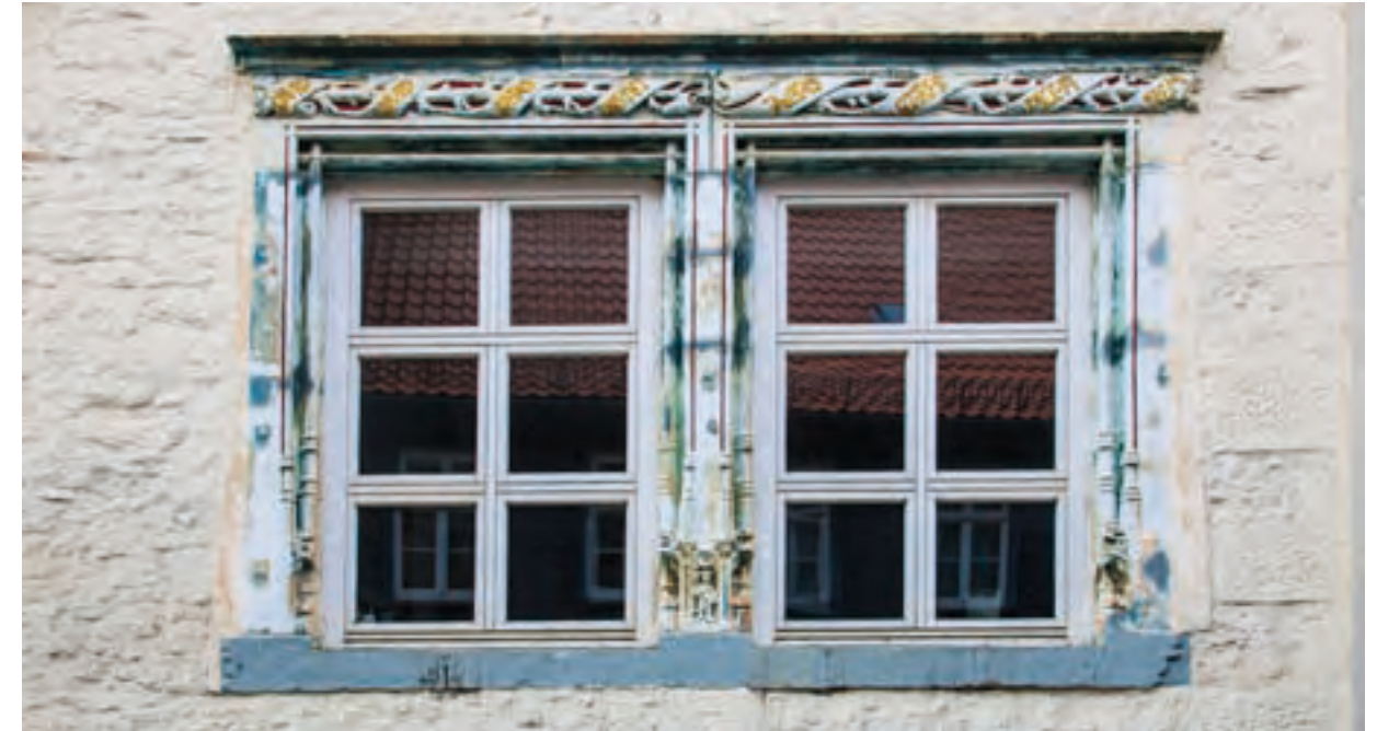
Abb. 181: Fensteröffnungen im Erdgeschoss des Wohnteils.
