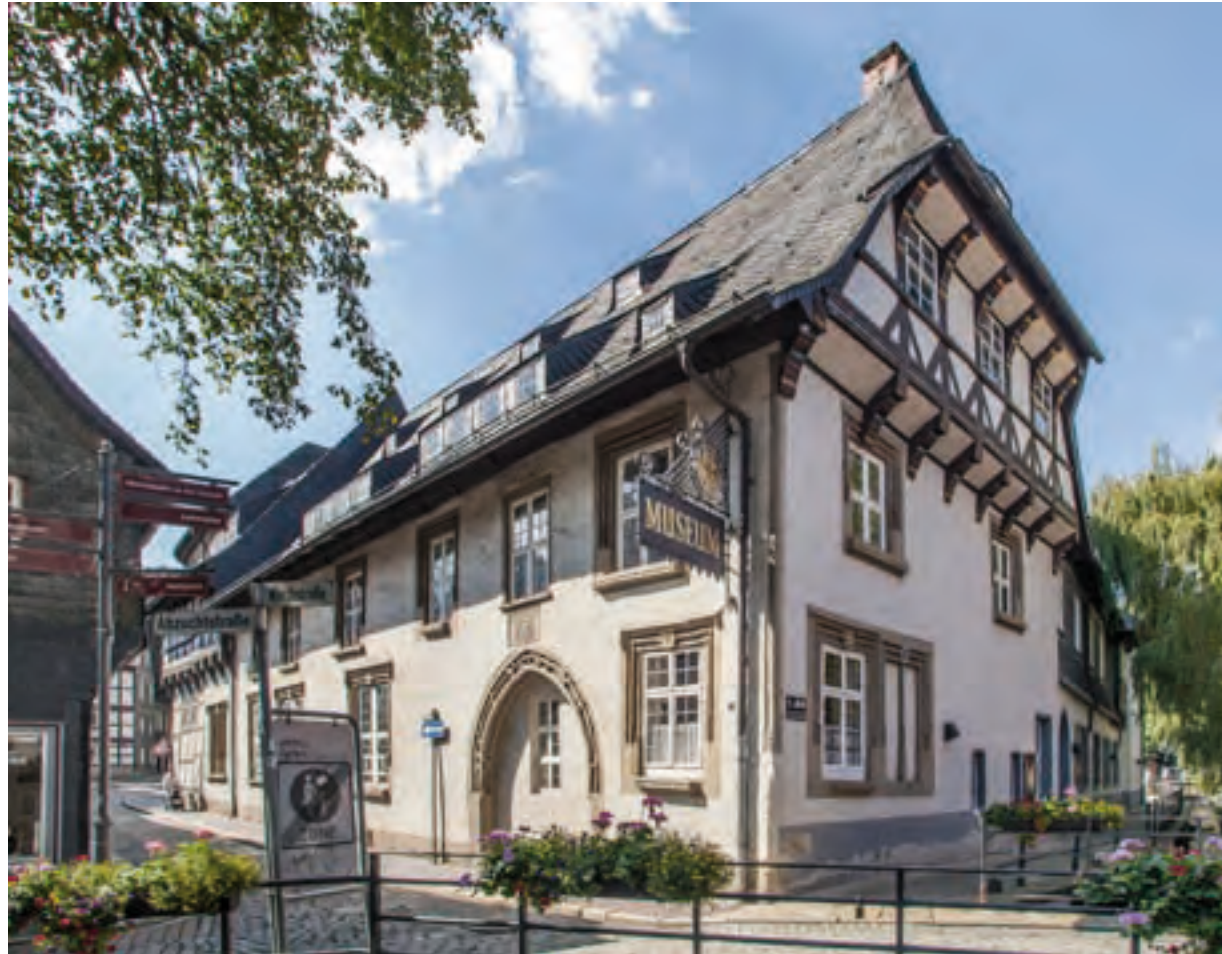
Abb. 90: Königstraße 1 (Goslarer Museum, Hauptgebäude), Nordostansicht mit Giebelseite zur Abzucht.
