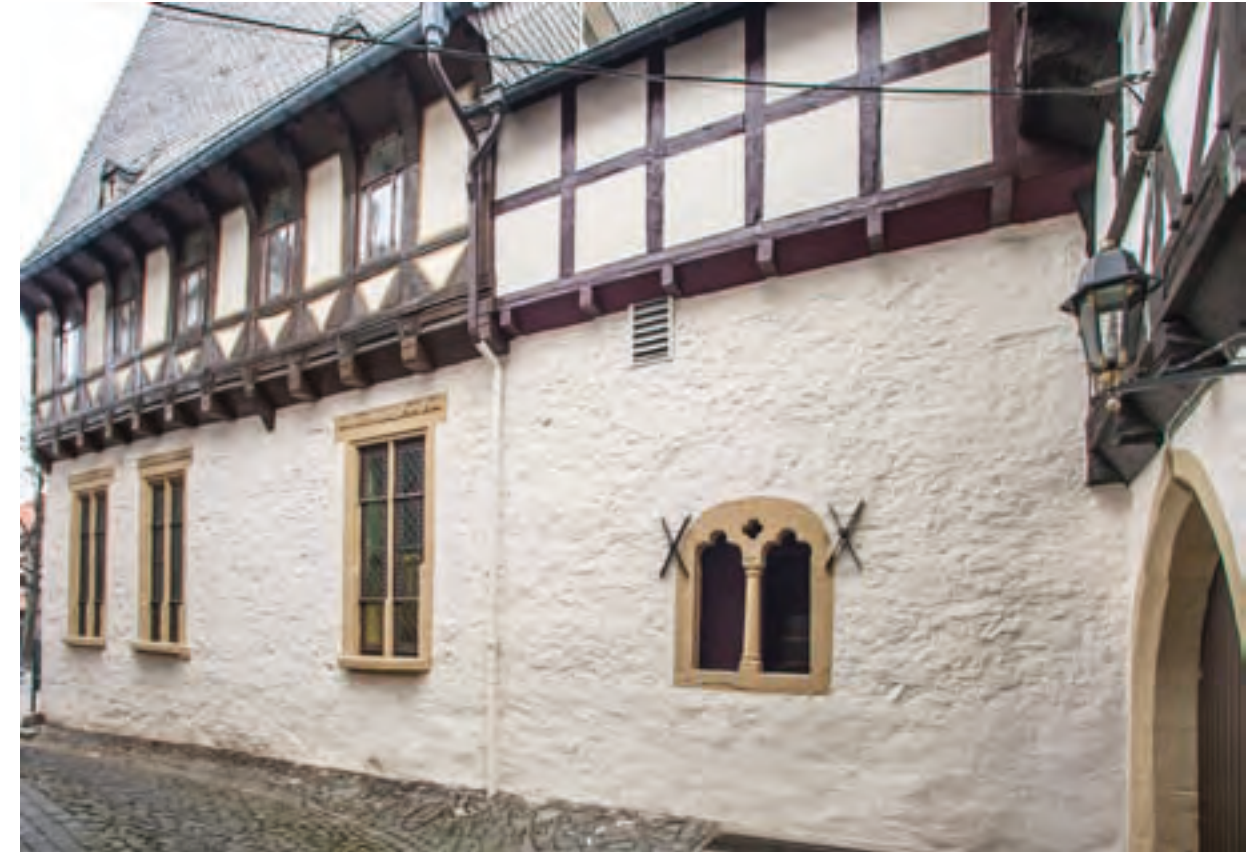
Abb. 62: Westfassade mit spätgotischen Dielenfenstern und spätromanischem Doppelfenster (Biforium) am Südende des steinernen Fassadenteils (rechts). Eine Baufuge ist zwischen Vorderhaus und Anbau (Kemenate) augenscheinlich nicht erkennbar.
