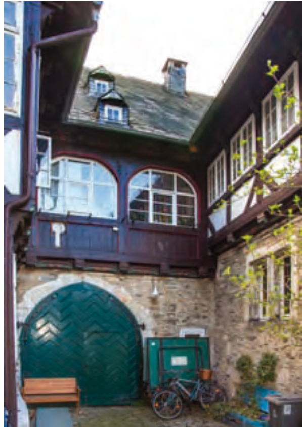
Abb. 125: Außenansicht des Hofportals mit den flankierenden Anbauten. Die Fachwerkfassaden im Obergeschoss stammen von 1671 (1932 restauriert).
