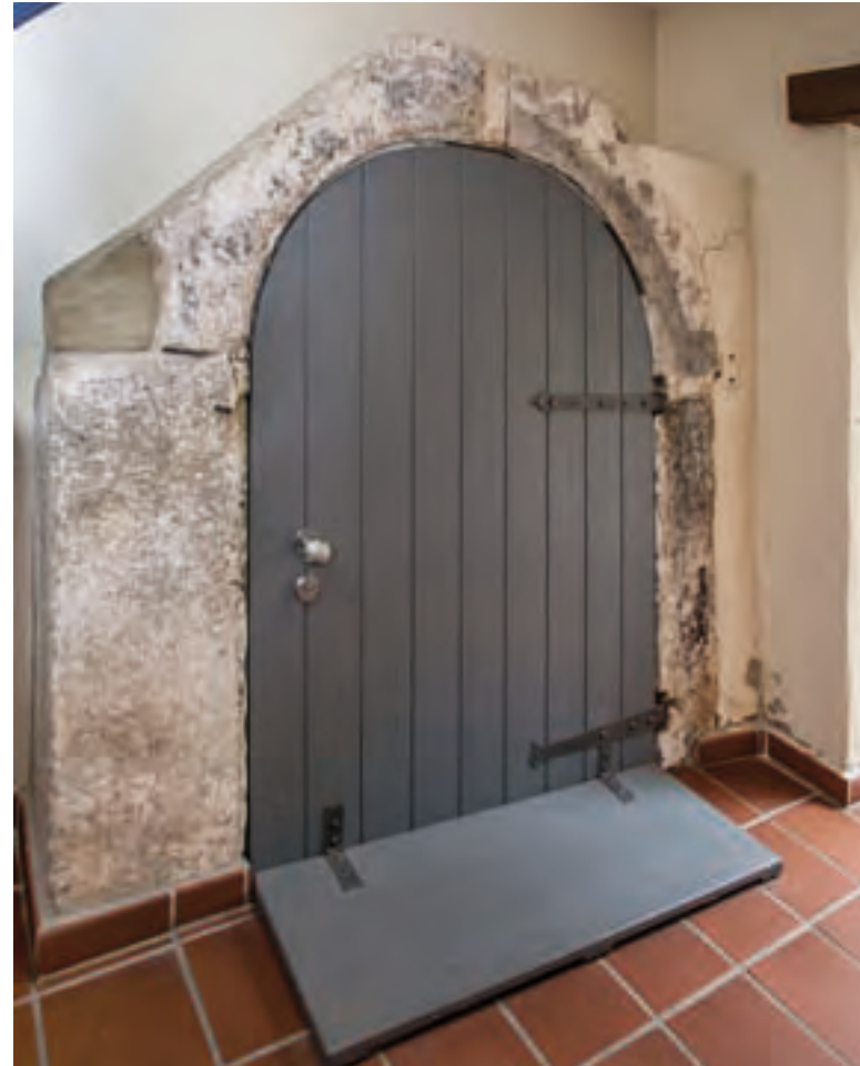
Abb. 164: Schreiberstraße 2, Treppenhaus, Rundbogentür zur Kellertreppe im Erdgeschoss mit Farbfassung.
