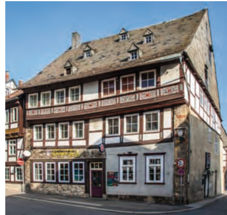
Abb. 47: Das Haus Marktstraße 15 zeigt zweigeschossige Brandmauern und ein massives Erdgeschoss. Die heutige, von reichverziertem Fachwerk geprägte Erscheinung des mittelalterlichen Steinbaus stammt aus dem 17. Jahrhundert.
