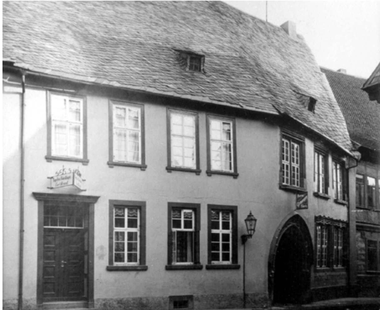
Abb. 142: Bergstraße 5, Südfassade vor dem Brand 1913.
