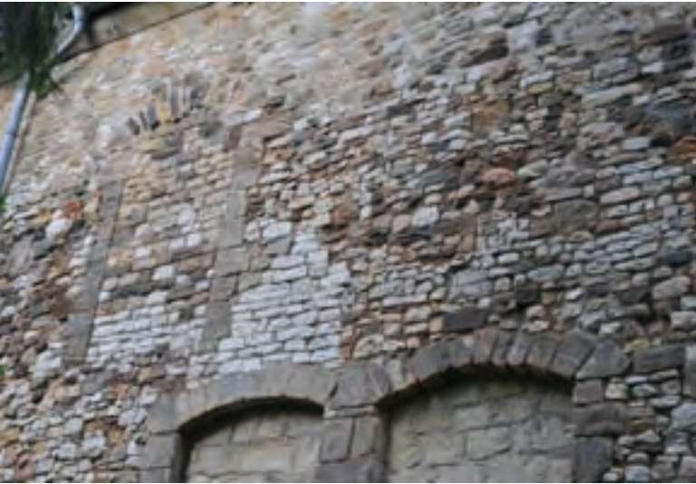
Abb. 20: Kaiserpfalz (Rückseite), bestehend aus Lese- und Bruchsteinen (dunkles Gestein) in Kombination mit Kalkstein (weißes Gestein). Die Fenster sind mit Sudmerberger Kalksandstein ausgemauert. Die Fenstergewände sind aus Hilssandstein gearbeitet.
