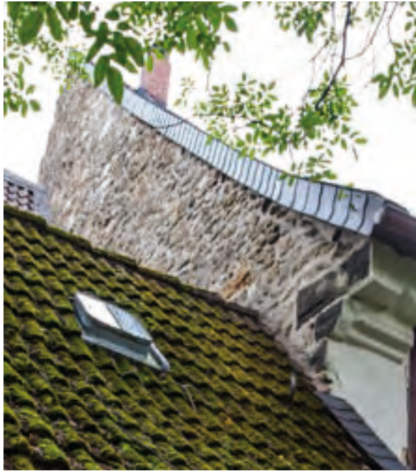
Abb. 179: Blick von Nordwesten auf den nördlichen Brandgiebel. Der asymmetrische Bruchsteingiebel reicht bis an die Rückfront des hofseitigen Fachwerkanbaus.
