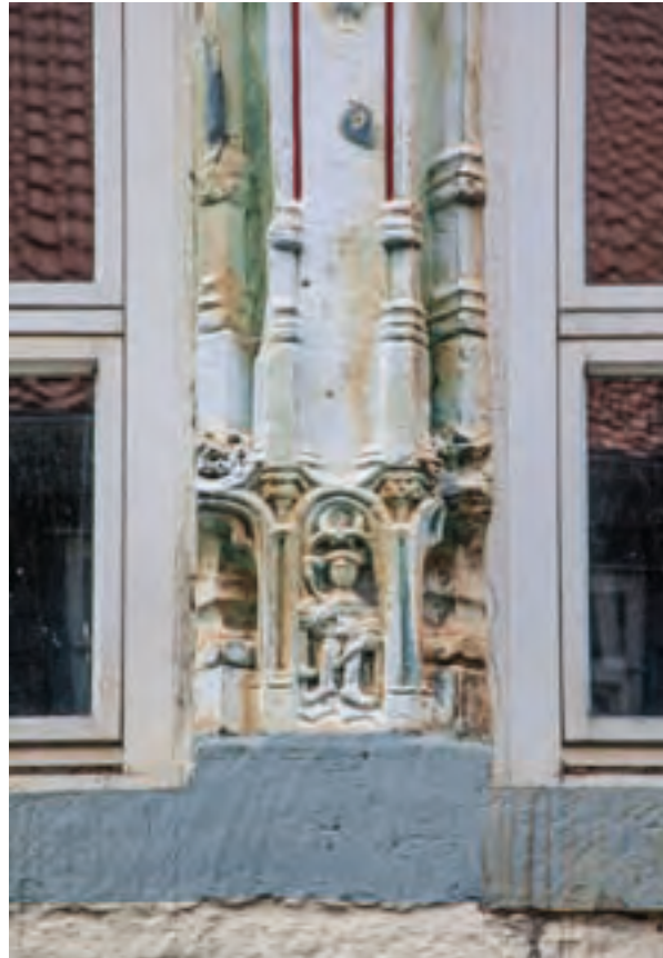
Abb. 183: Detail des Obergeschossfensters, Mittelpfeiler mit Miniaturarkade. Innerhalb der Pfeilerarkade Reliefdarstellung einer Kriegerfigur. Ähnliche Figuren finden sich auf zeitgenössischen Darstellungen, so bei Lucas Cranach.
