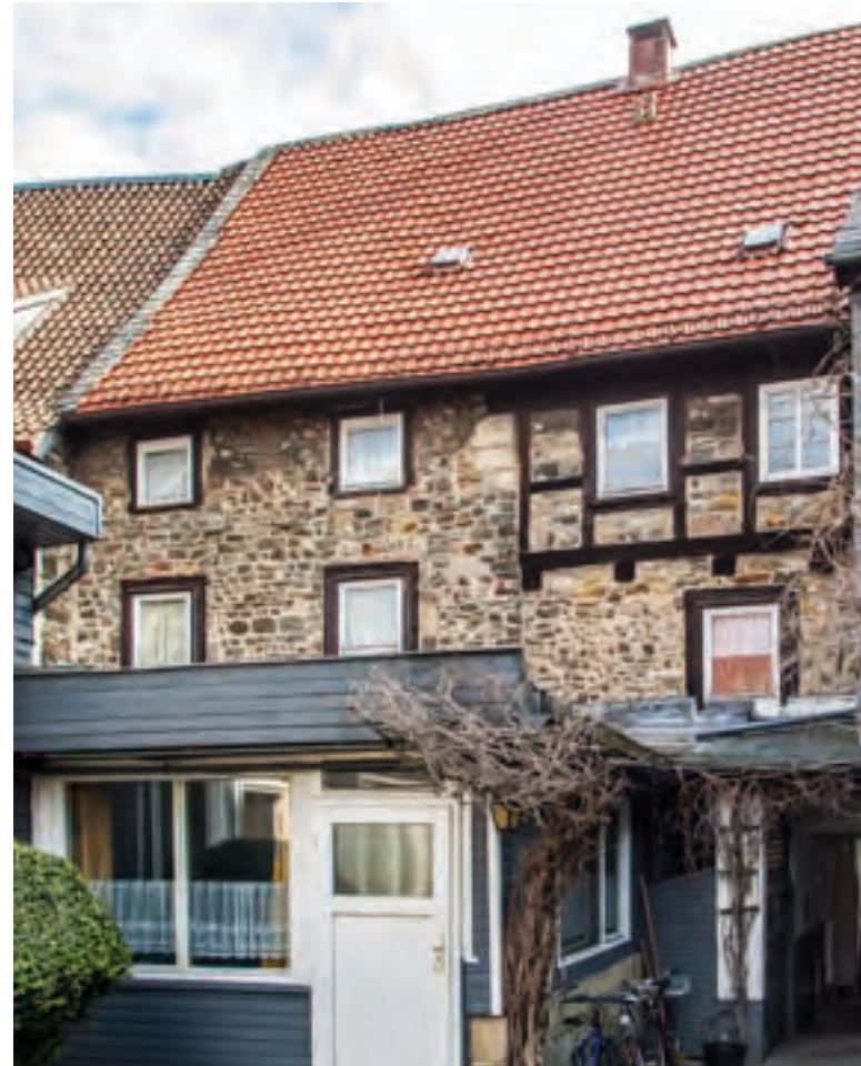
Abb. 167: Rückfront des Steinhauses Schreiberstraße 11 mit Kemenate (links) und Speicherstock aus Fachwerk (wohl von 1502). Rechts: Hofdurchfahrt.
