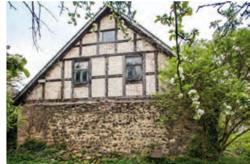
Abb. 226: Nordgiebel des Hofgebäudes mit massivem Erdgeschoss.
