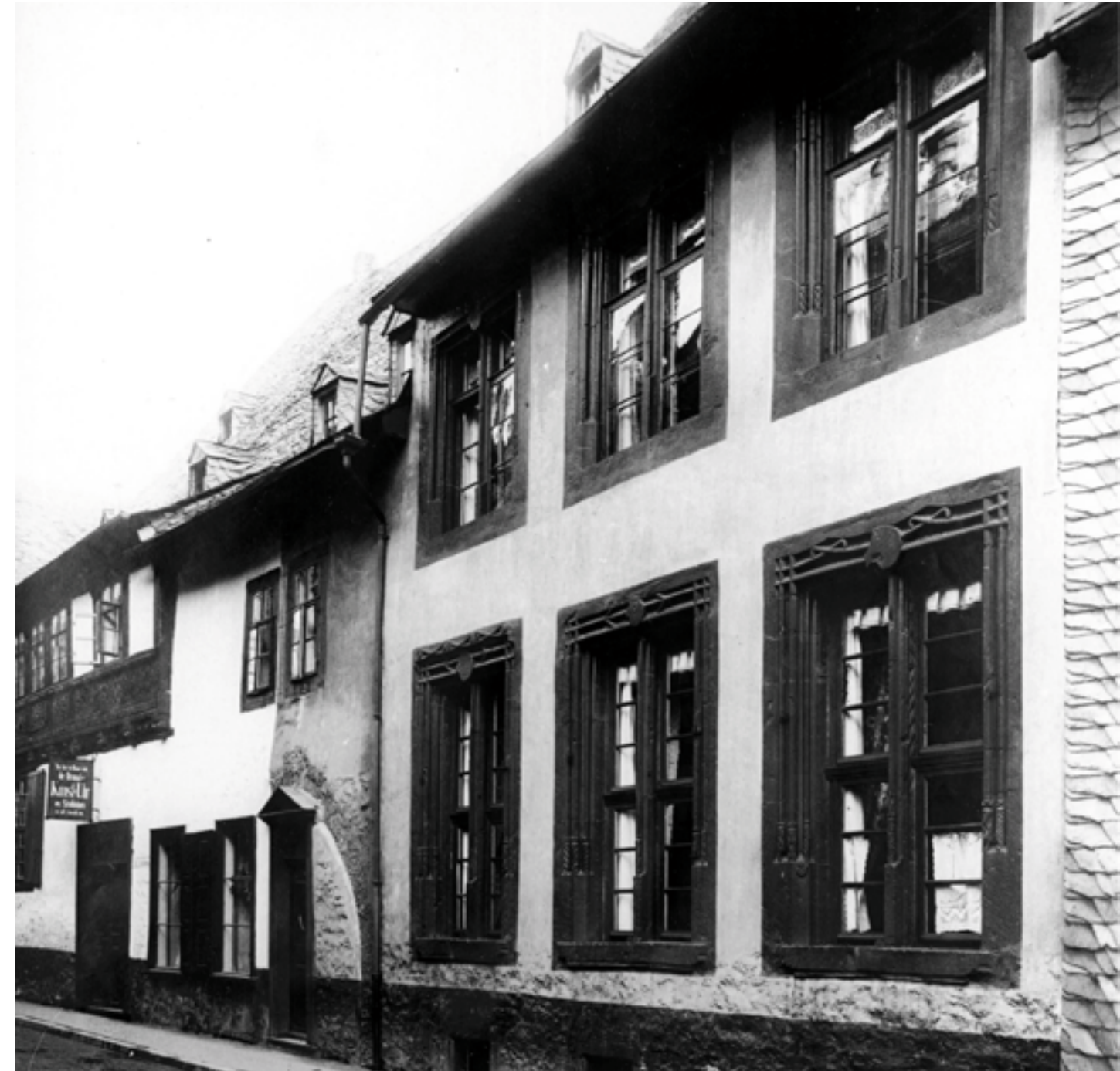
Abb. 80: Worthstraße 7 und 8, Zustand um 1900. Das im Kern mittelalterliche Haus Nr. 8 (links, 1990 ausgebrannt und abgebrochen) zeigte ein Spitzbogenportal zur Diele (nachträglich zu Türöffnung verkleinert). Im Wohnteil war seine Straßenfront mit einem Fachwerkobergeschoss (Datierung 1648) umgebaut worden.
