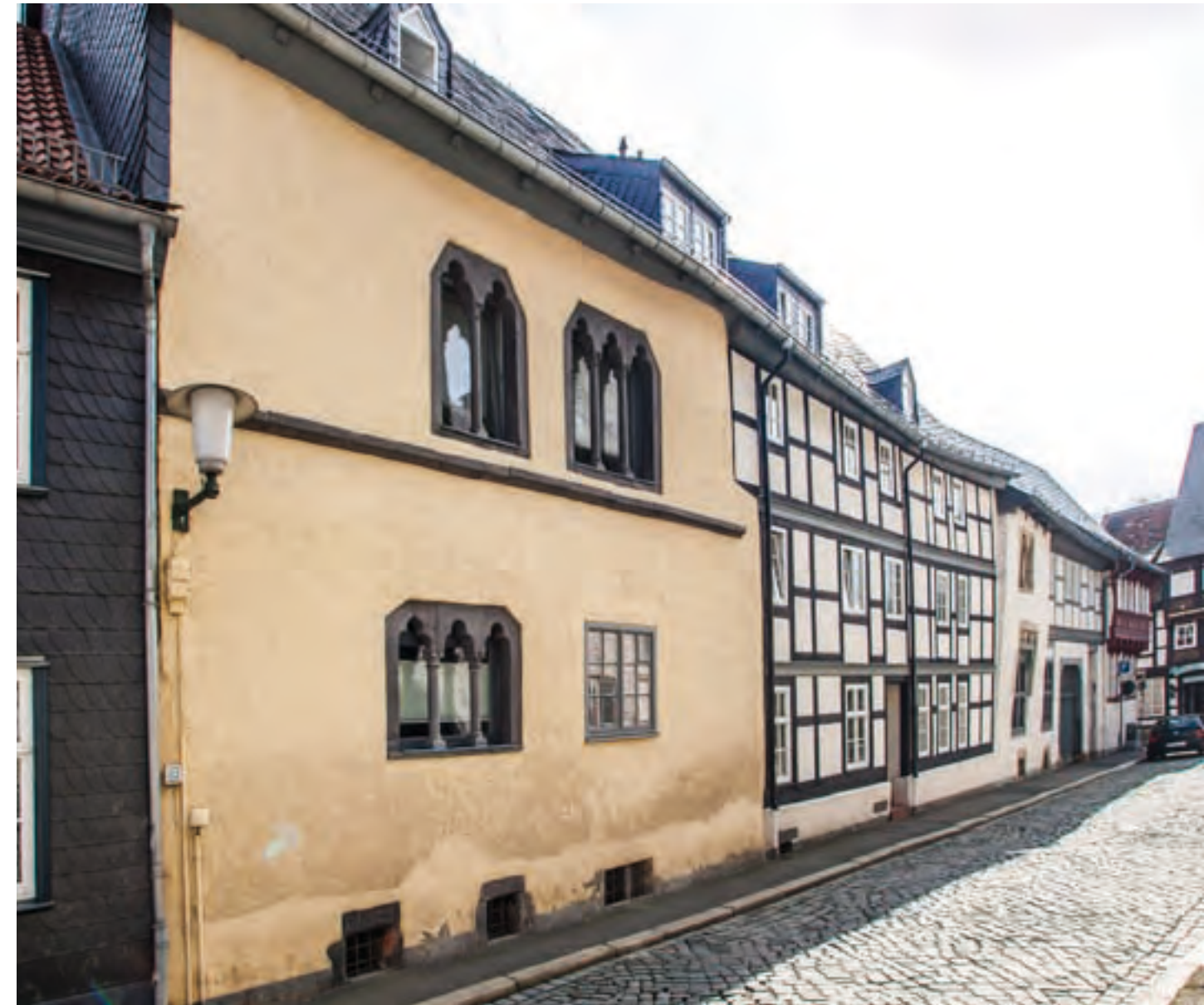
Abb. 158: Schreiberstraße 2, Blick auf die Straßenfront. Neben der frühgotischen Kemenate ist der Dielenbereich als dreigeschossiger Stockwerk-Wohnbau m 1800 in Fachwerk erneuert worden. Am Ansatz des Fachwerkbbaus deutet ein Versprung der Kemenatenfassade auf einen ursprünglich möglicherweise steinernen Dielenteil.
