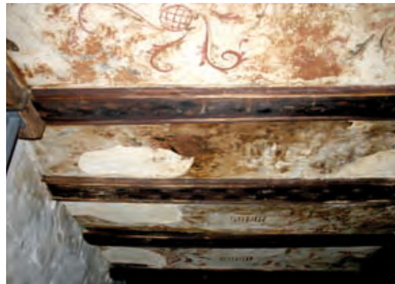
Abb. 114: Balkendecke (von 1186) über dem Zwischengeschoss. Die Balken zeigen nachträglich untergesetzte Profilbohlen. Die Decke weist eine Rankenbemalung aus um 1500 auf. In die Malereien sind Schriftzüge der Namen von Heiligen integriert, noch zu lesen sind „Maria“ und „Niklus“
