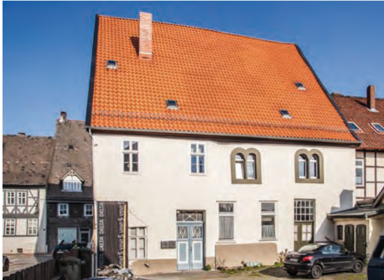
Abb. 131: Rückfront mit zwei rundbogigen Doppelfenstern im Ostteil des Obergeschosses. Die übrigen Fenster- und Türöffnungen stammen in ihrer heutigen Form aus dem 19. und 20. Jahrhundert.
