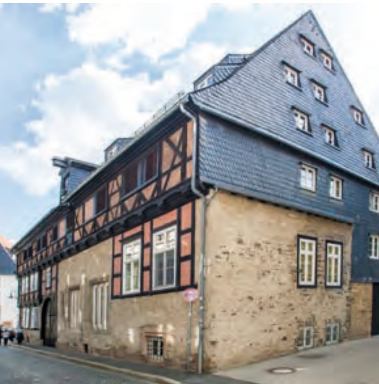
Abb. 46: Bergstraße 55 gehört zu den stattlichsten alten Bürgerhäusern Goslars. Das Bauwerk zeigt eine teilweise massive Diele und einen unterkellerten Wohnteil, dessen Straßenfront in Fachwerk erneuert ist (wohl 18. Jh., rechts). Linker Hausteil und Speichergeschoss zeigen ein schönes Barockfachwerk aus der Zeit um 1700.
